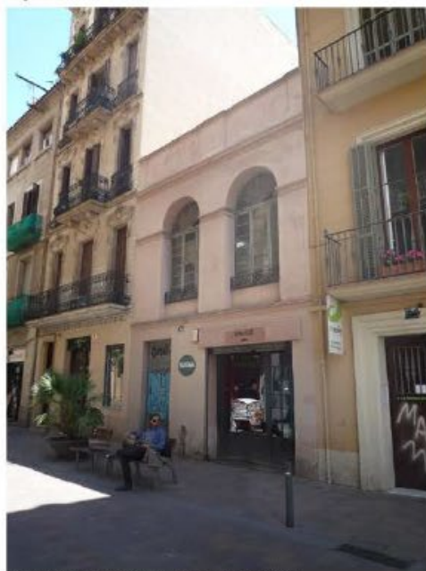
Finca afectada perllongament carrer de l'Àngel. Façana carrer Astúries
