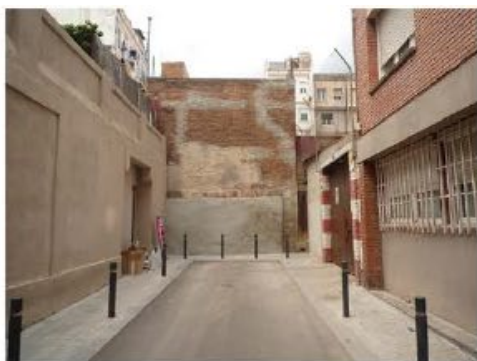
Finca afectada perllongament carrer de l'Àngel. Façana sud
