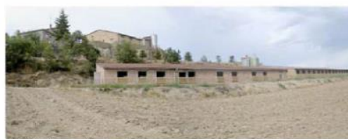
Vista de la façana sud de la granja
