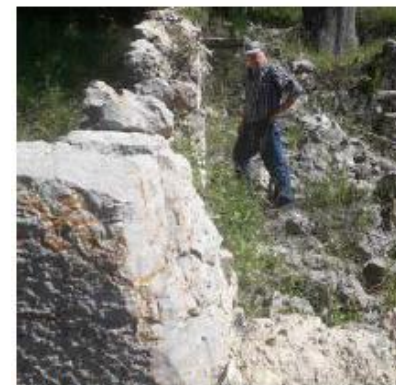
Façana oest. Vista longitudinal.
