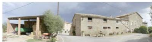
Vista de les façanes nord-oest
