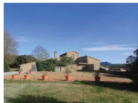
1. Vista sud-oest del conjunt
