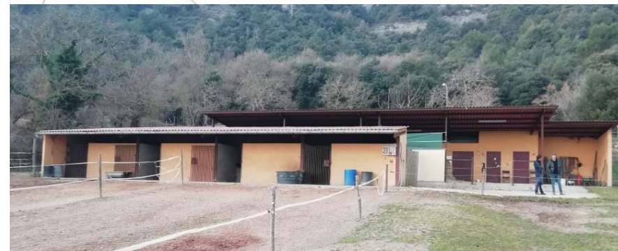
Cobert Equí. Estat actual
