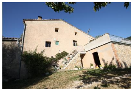
Volum A i volum B - Façana principal sud-oest
