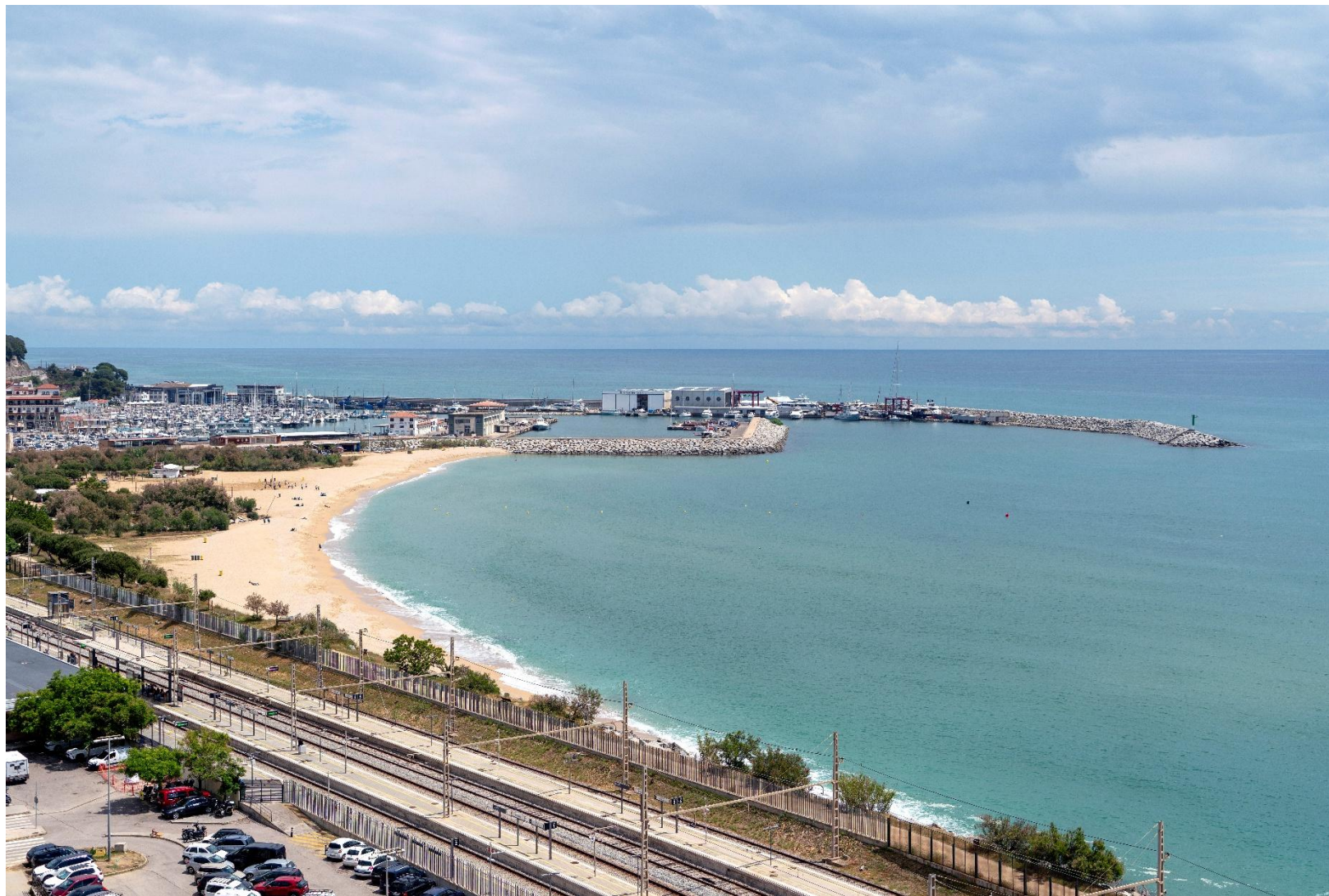
Imatge 1. Vista de l'estat actual des del punt de vista PV01 – Turó del cementiri.
