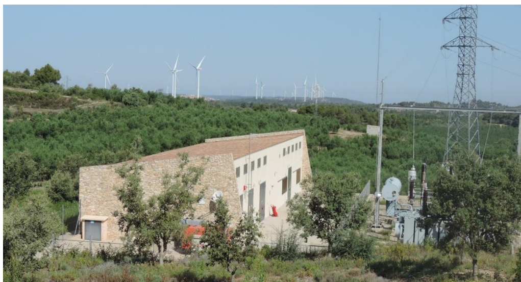
Foto 17. Subestació de la central eòlica de les Rotes, al terme de Bellaguarda.
