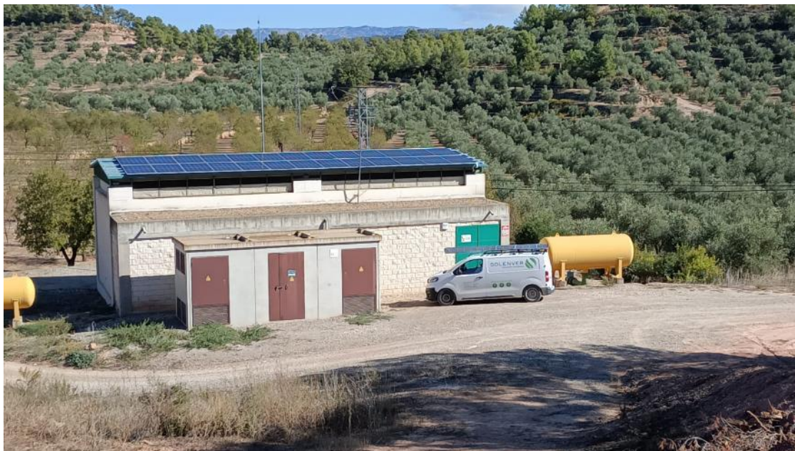
Foto 15. Estació de bombeig de la Granadella.
