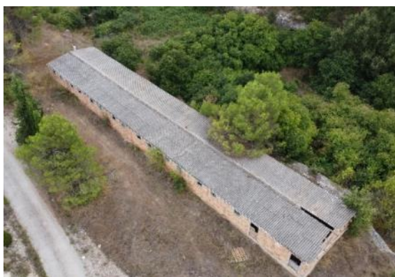
Foto 2 i 3. Granges de porcs en desús, amb parament de totxana i coberta de fibrociment.
