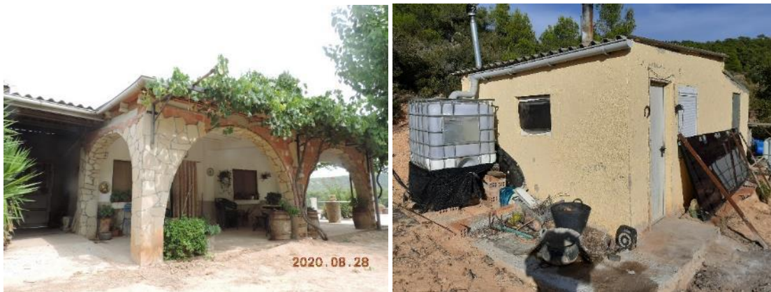
Foto 19 i 20. Edificacions destinades a habitatge en sòl no urbanitzable i sense llicència municipal.
