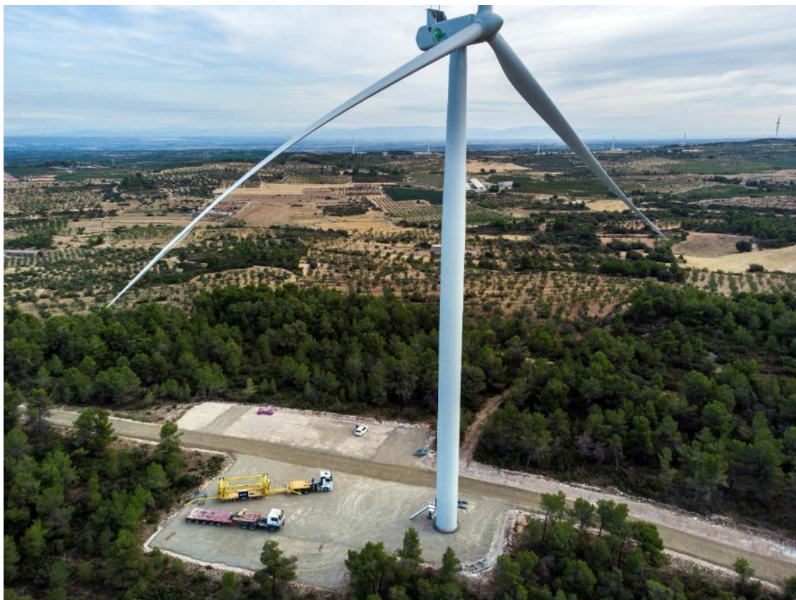
Foto 17. Central eòlica en fase final d'instal·lació entre els termes de Llardecans i la Granadella.
