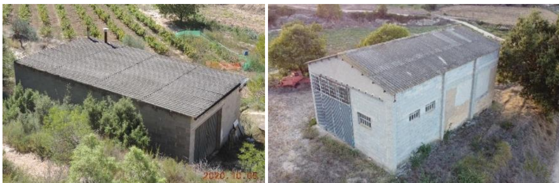
Foto 10 i 11. Magatzems agrícoles dels anys 90 i 2000 amb bloc de formigó i coberta de fibrociment.
