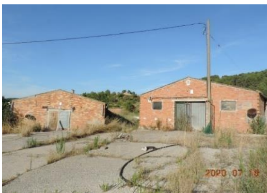
Foto 2 i 3. Granges de porcs en desús, amb parament de totxana i coberta de fibrociment.
