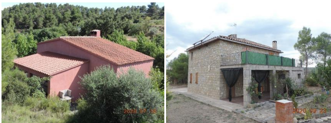
Foto 21 i 22. Edificacions destinades a habitatge en sòl no urbanitzable i sense llicència municipal.
