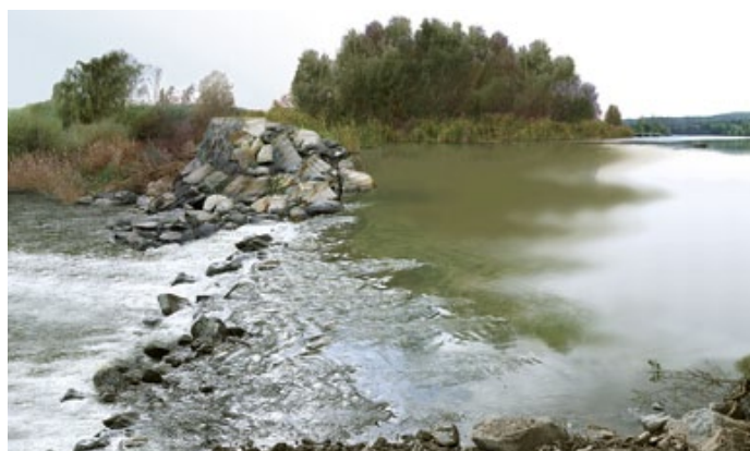
Figura 17. Restauració de la connectivitat longitudinal en un riu per mitjà de l'enderrocament parcial d'una resclosa, que ha de permetre restaurar els desplaçaments de la pràctica totalitat dels individus de totes les espècies de peixos. Il·lustració d'Acíclic a partir d'una altra d'Ordeix i altres (2007).
