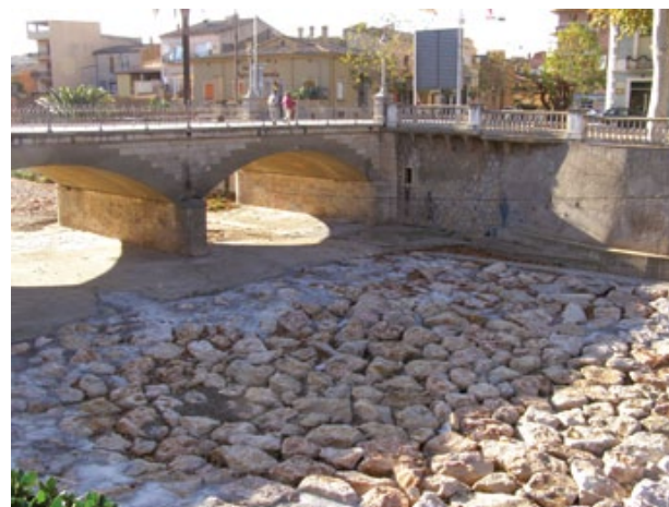
Figura 31. Rampa de fons a la base d'un pont del riu Daró (la Bisbal d'Empordà, el Baix Empordà). Any 2006. Fotos: Quim Pou-CERM.
