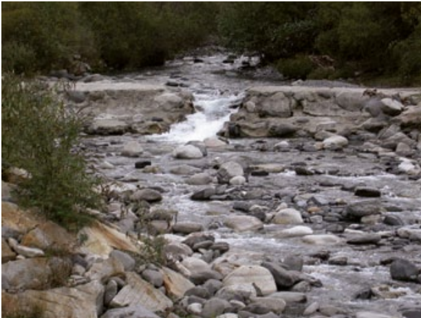
Figura 30. Enderrocament parcial d'un dic de retenció de sediments a la confluència entre el riu Jòeu i la Garona (Es Bòrdes, Val d'Aran). Any 2010. Fotos: Marc Ordeix-CERM.
