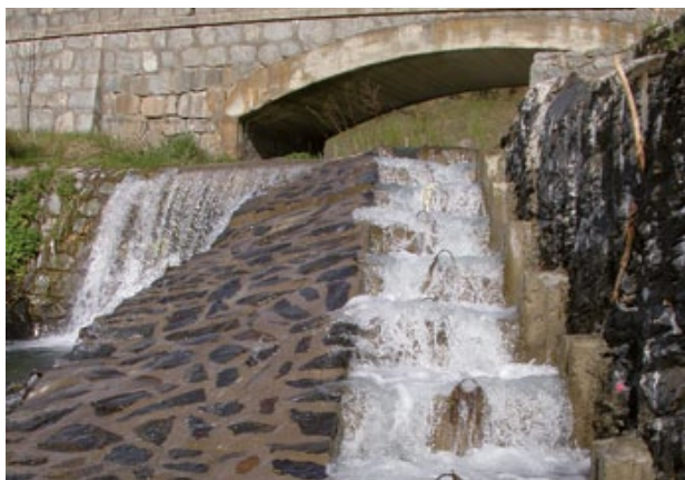
Figura 26. Dos exemples de solucions per millorar la connectivitat per als peixos als rius de Catalunya: 1) una solució de restauració: enderrocament parcial d'un dic de retenció de sediments al riu Jòu a Es Bòrdes, Val d'Aran (a dalt), i 2) una solució de rehabilitació: un dispositiu de pas per a peixos de caràcter tècnic del tipus de safareigs successius amb salts al riu Ter a Setcases, el Ripollès (a baix). Fotos: Marc Ordeix-CERM.
