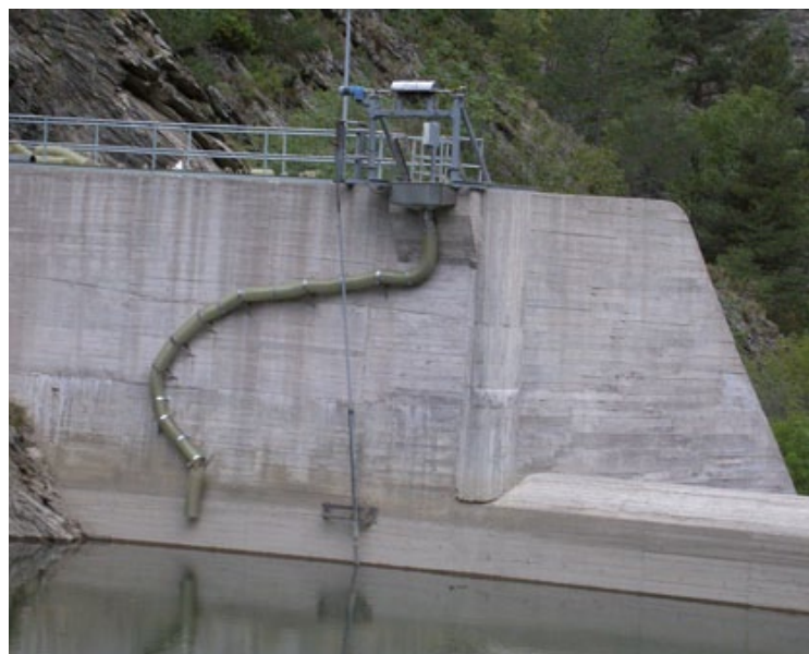
Figura 35. Ascensor per a peixos de la resclosa del Mal Pas, riu Romadriu o de Santa Magdalena (Llavorsí, el Pallars Sobirà). Any 2006. Foto: Marc Ordeix-CERM.
