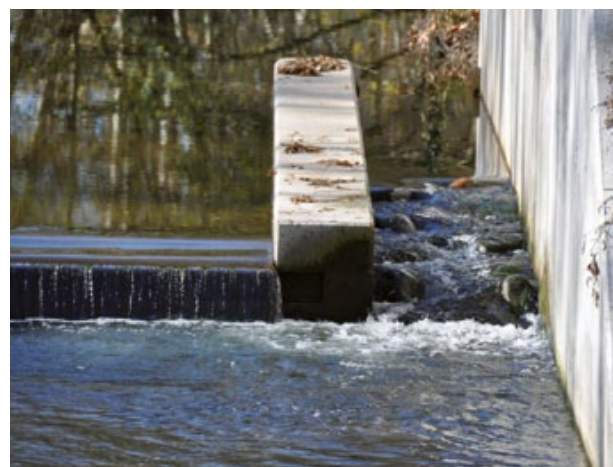
Figura 32. Rampa per a peixos de l'Estació d'Aforament del riu Fluvià a Olot (la Garrotxa). Any 2010. Fotos: Marc Ordeix-CERM.
