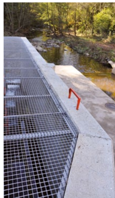
Figura 25. Emplaçament de dues antenes rectangulars instal·lades en sèrie i del conjunt de l'equip de detecció en continu de marques PIT (o PIT tags) a l'entrada aigua avall i a la sortida aigua amunt del dispositiu de pas per a peixos de l'estació d'aforaments 009 de la Llèmena, a Ginestar de Llèmena (Sant Gregori, el Gironès), i buidatge de dades del data logger de l'antena superior el novembre de 2010. Fotos: Marc Ordeix-CERM.
