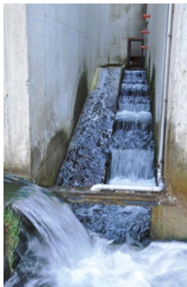
Figura 25. Emplaçament de dues antenes rectangulars instal·lades en sèrie i del conjunt de l'equip de detecció en continu de marques PIT (o PIT tags) a l'entrada aigua avall i a la sortida aigua amunt del dispositiu de pas per a peixos de l'estació d'aforaments 009 de la Llèmena, a Ginestar de Llèmena (Sant Gregori, el Gironès), i buidatge de dades del data logger de l'antena superior el novembre de 2010. Fotos: Marc Ordeix-CERM.
