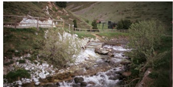
Figura 28. - Dispositiu de pas per a peixos de safareigs successius amb salts on manca un safareig o gorg amb prou profunditat a l'entrada del dispositiu. El Torrent de Finestreslles al Santuari de Núria, el Ripollès. Fotos: Marc Ordeix-CERM.
