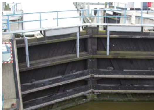
Comportes de regulació o protecció i encluses de navegació
