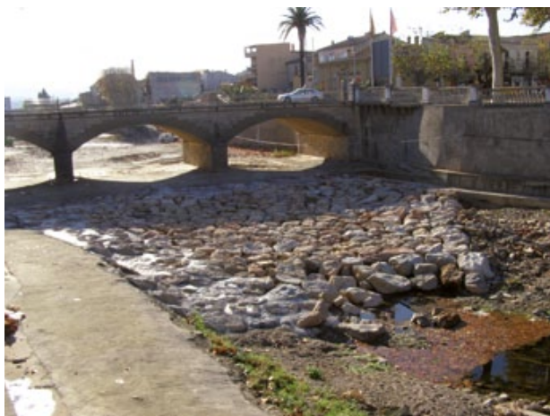
Figura 31. Rampa de fons a la base d'un pont del riu Daró (la Bisbal d'Empordà, el Baix Empordà). Any 2006. Fotos: Quim Pou-CERM.
