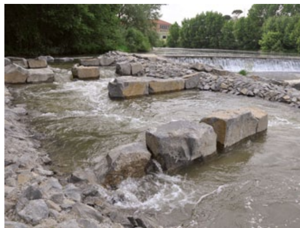
Figura 34. Rampa per a peixos de la resclosa de la Teula (riu Ter a Manlleu, Osona). Maig de 2011. Fotos: Marc Ordeix-CERM.
