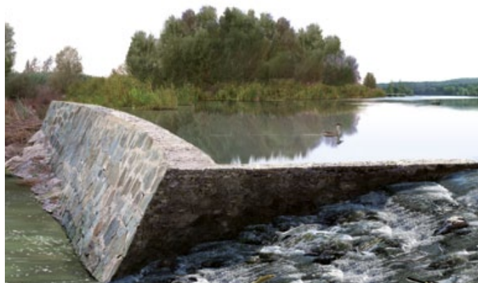
Figura 18. Rehabilitació de la connectivitat longitudinal en un sector de riu per mitjà d'un bon dispositiu de pas per a peixos proper a la natura (concretament, una rampa per a peixos) en una resclosa. Ha de permetre el trànsit de la majoria dels grups de peixos presents potencialment i pràcticament en qualsevol situació hidrològica. Il·lustració d'Ordeix i altres (2007).
