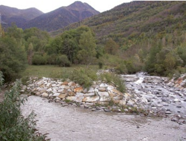
Figura 30. Enderrocament parcial d'un dic de retenció de sediments a la confluència entre el riu Jòeu i la Garona (Es Bòrdes, Val d'Aran). Any 2010. Fotos: Marc Ordeix-CERM.
