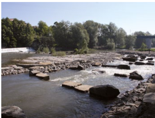
Figura 34. Rampa per a peixos de la resclosa de la Teula (riu Ter a Manlleu, Osona). Maig de 2011. Fotos: Marc Ordeix-CERM.
