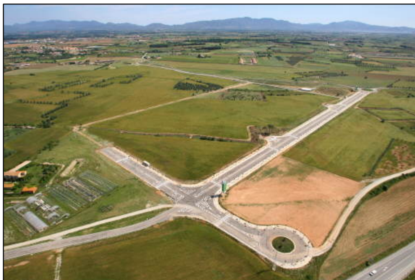
Foto 7.4.1-3: Vista aèria dels terrenys del futur LOGIS Empordà (Font: CIMALSA).
