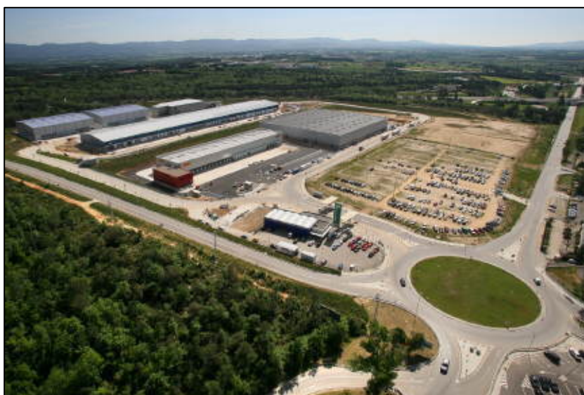
Foto 7.4.1-1: Vista aèria de la CIM la Selva (Font: CIMALSA).
