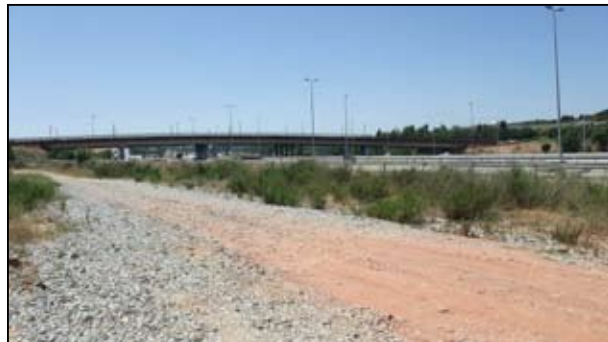
Viaducte sobre l'AP-7 que arrenca del final del torrent de can Domènec. Posa de manifest la magnitud de la separació territorial entre ambdós costats.
