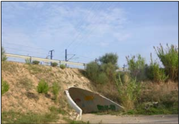
Pas de la riera de l'Adoberia per sota de la línia del tren d'alta velocitat en el terme de Vilafranca del Penedès.
