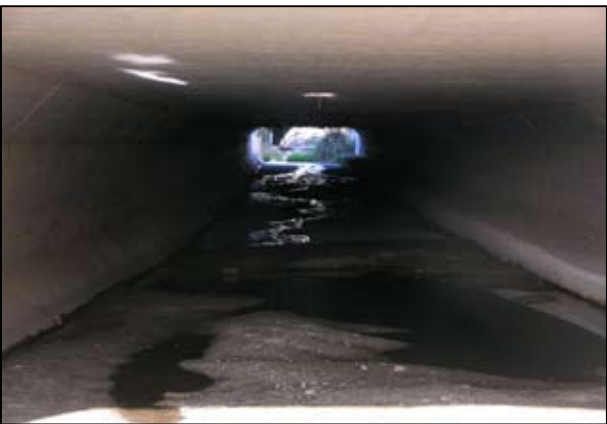
Pas inferior del torrent del Meniu. Aquesta riera està canalitzada totalment des de que creua la C-31D i la C-32.
