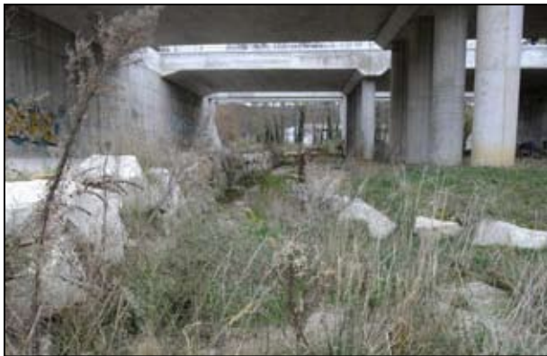
Pas de fauna en el torrent de Palomeres construït sota el tren d'alta velocitat i dins les actuacions previstes en la declaració d'impacte ambiental de l'obra.
