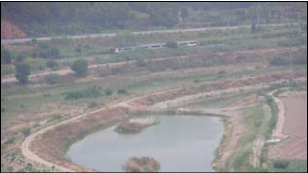
Les traces ferroviàries de l'AVE i de la línia de Rodalies circulen resseguint el curs fluvial.
