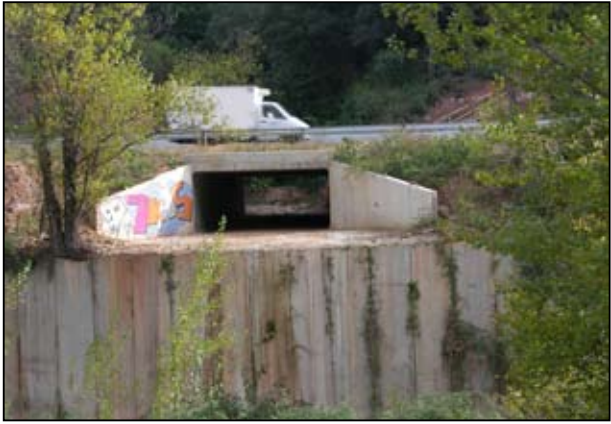
Torrent de can Xesc passant per sota la C-17 amb un salt d'uns cinc metres sobre el riu Congost.
