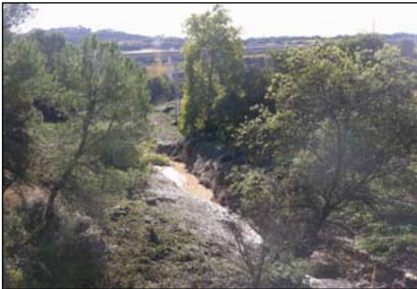
Riera de Lavernò des del pont de la carretera C-243a, amb la traça del tren d'alta velocitat al fons.
