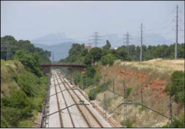
La via del tren Barcelona-Manresa amb passos elevats, però insuficients.
