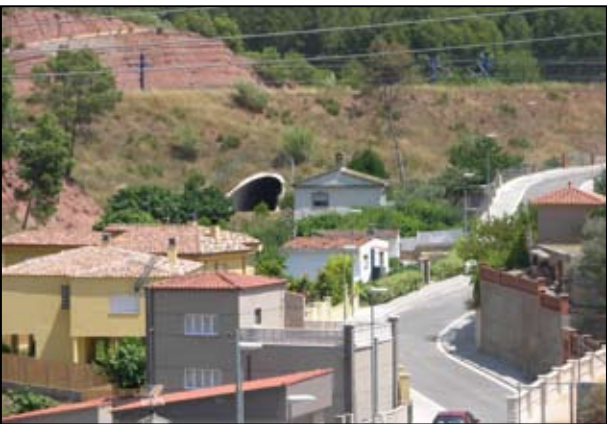
Pas soterrat d'un torrent a la urbanització de Costablanca.
