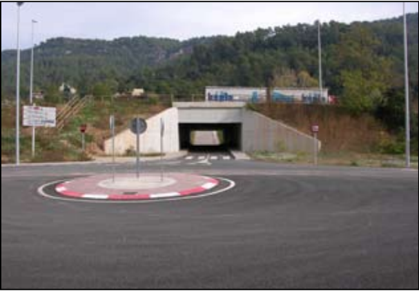
Pas d'accés per sota la C-17 cap a Tagamanent davant del torrent de la Guillotera.
