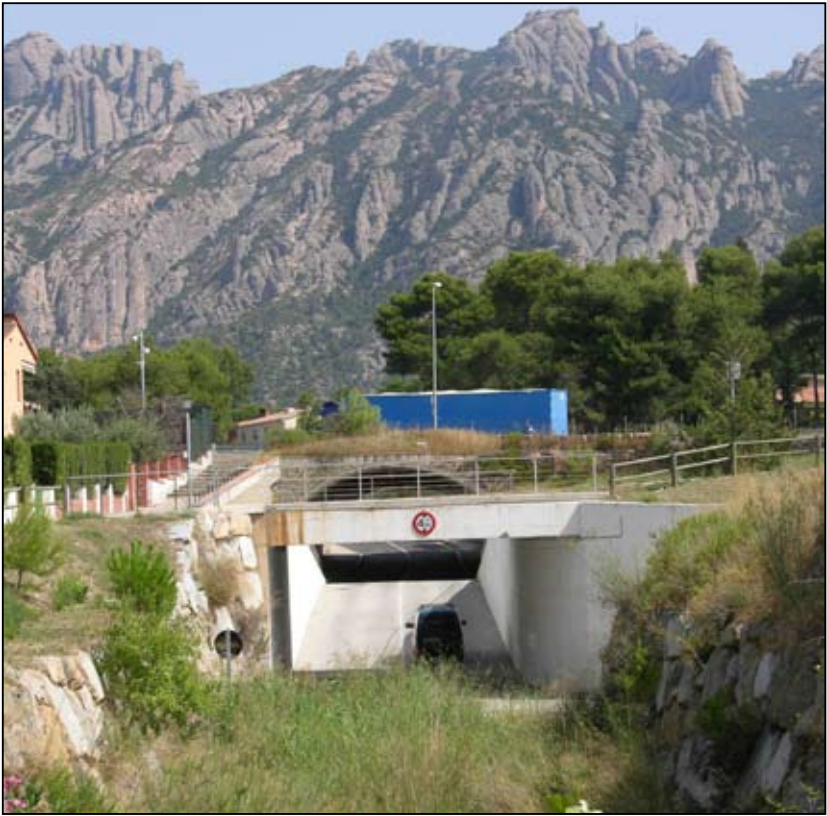
Pas artificialitzat sota l'autopista en el qual el torrent de la Vinya Nova es combina amb un gual per a vehicles motoritzats per travessar sota l'A-2.
