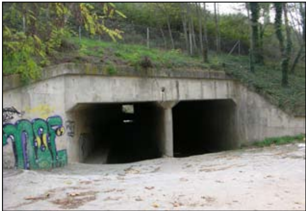
Pas inferior de la riera de Vallodoriolf sota l'autopista AP-7.
