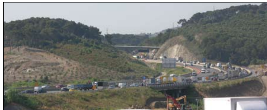
El coll de Montcada travessat per la C-58. Aquesta via, amb una elevada densitat de trànsit, constitueix una veritable barrera per a la connectivitat.
