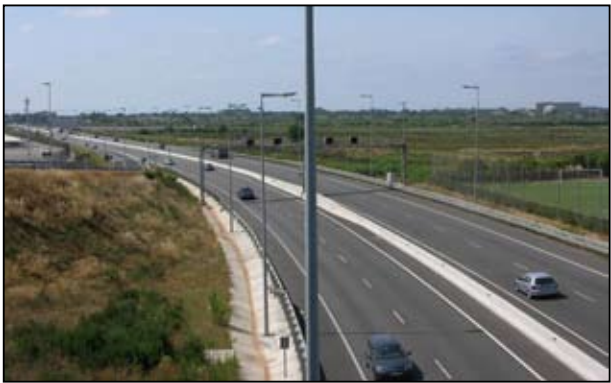
Autovia de Castelldefels, C-31, una traça viària molt poc permeable.
