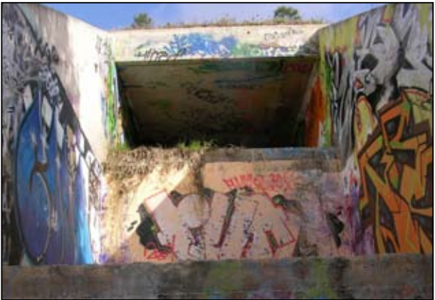
El disseny en grada del pas del torrent de Pallerols per sota el nus viari representa una barrera infranquejable per a moltes espècies.
