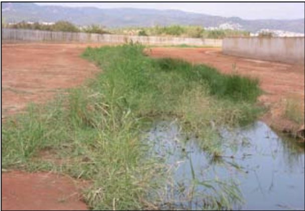
Rastres de naturalització en el tram final de la canalització de la riera de Sant Climent.
