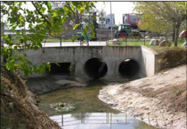
Torrent de Sagols travessant el polígon industrial de Sant Pere Molanta, en el terme municipal d'Olèrdola.
