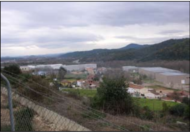
El nou polígon industrial de Gualba ubicat sobre el punt de connexió Montseny-Montnegre a través de la riera de Gualba-riera de Montnegre.
