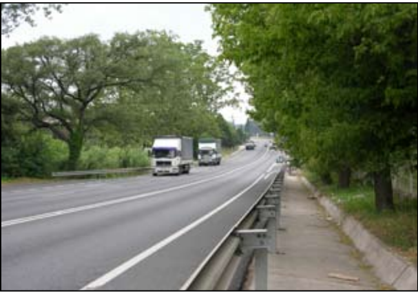
Carretera B-140 en el sector de Santiga.
