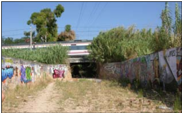
Inici de la canalització de la riera dels Canyars des del pont del ferrocarril.
