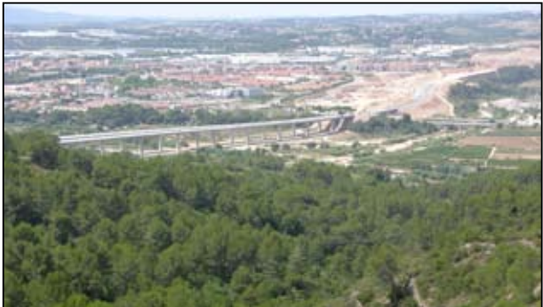
Viaducte sobre el riu Llobregat de la futura Ronda del Vallès. Al fons el nucli urbà d'Abrera.
