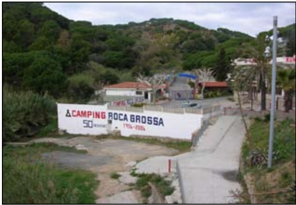
Ocupació de la llera del torrent de la Cabra per una instal·lació turística a tocar de la línia de mar.
