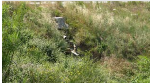
Pas mínim del torrent de can Miró per sota l'autopista AP-7.
