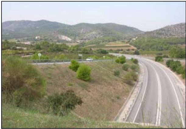
La carretera C-15B vista des del pas elevat del Palou Alt. Al fons, la riera de Begues la creua.
