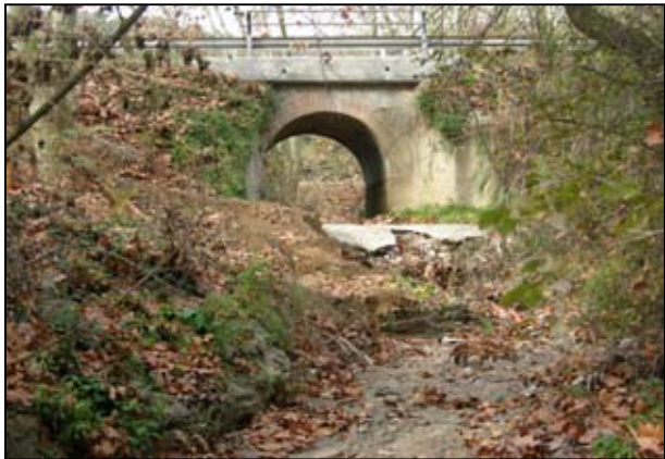
Pont sobre el Sot del Virol, en el punt que travessa la carretera de Dosrius a Canyamars.
