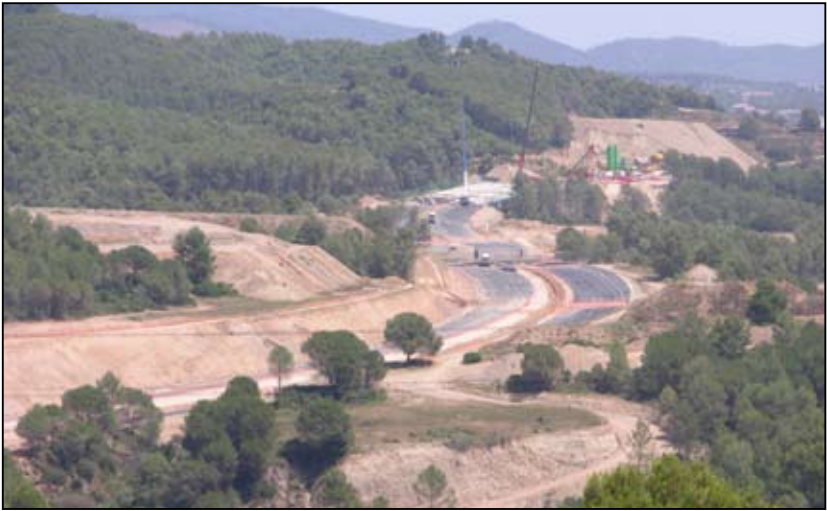
Impacte paisatgístic de la Ronda del Vallès al costat Vallesà en el terme de Viladecavalls durant la seva construcció (Juliol, 2009).
