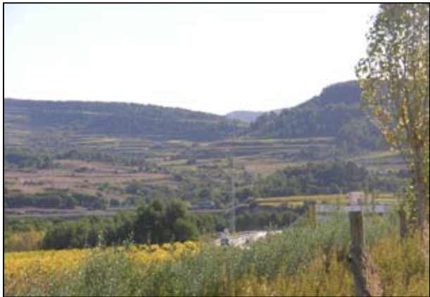
L'autopista AP-7 circula resseguint la vora del massís de l'Ordal en un recorregut sinuós, que contrasta amb el dels traçats ferroviaris.
