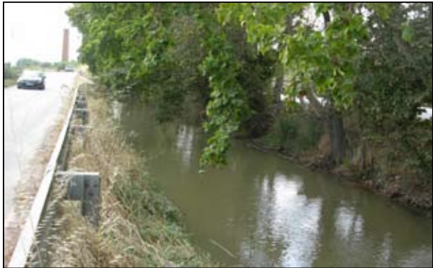
Canal de la Dreta del riu Llobregat que nodreix la plana agrícola d'aquest sector del Parc Agrari.
