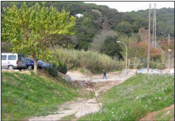
Gual inferior de la riera de Dosrius que separa en dos la vila. Un tram que podria ser renaturalitzat.
