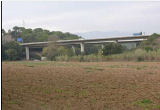
El viaducte de la C-60 sobre la riera de Gasuacs facilita la continuïtat d'aquesta important riera, que baixa de la serralada Litoral, amb el riu Mogent.
