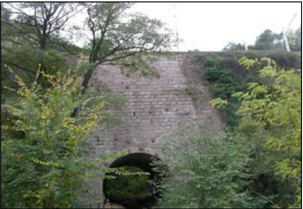
Pas de la via de ferrocarril sobre el torrent del fondo del Bac.
