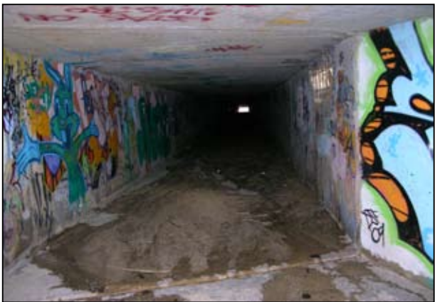
Pas subterrani del torrent de Pallerols per sota el nus viari entre Argentona i Mataró.
