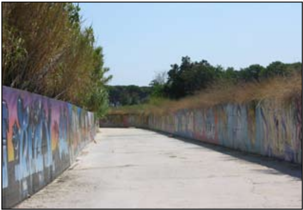
Tram de la riera de Polinyà totalment artificialitzada.
