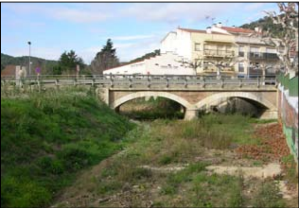
La xarxa hidrogràfica d'aquest indret, com el propi nom del municipi indica, destaca per la seva riquesa. Pont sobre la riera de Rials.
