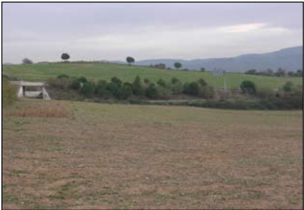
Pas del camí rural que connecta el sector agrari de La Torreta-Can Granota amb el de can Barló-Can Sora i Les Valls.
