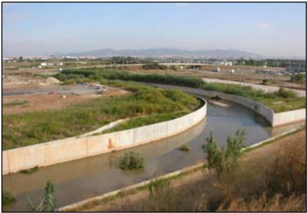
Canalització realitzada per al desguàs del sector de Sant Boi de Llobregat a l'alçada de l'accés a la terminal T1 de l'aeroport de Barcelona.
