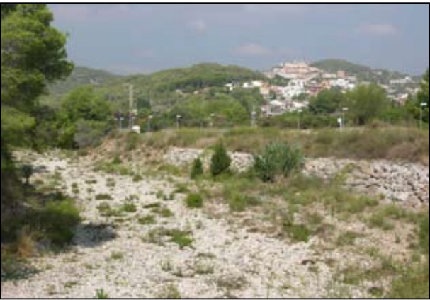
El riu Foix connecta alguns dels torrents o vessants del sector amb una estructura d'hàbitat adequat per a la permeabilitat.
