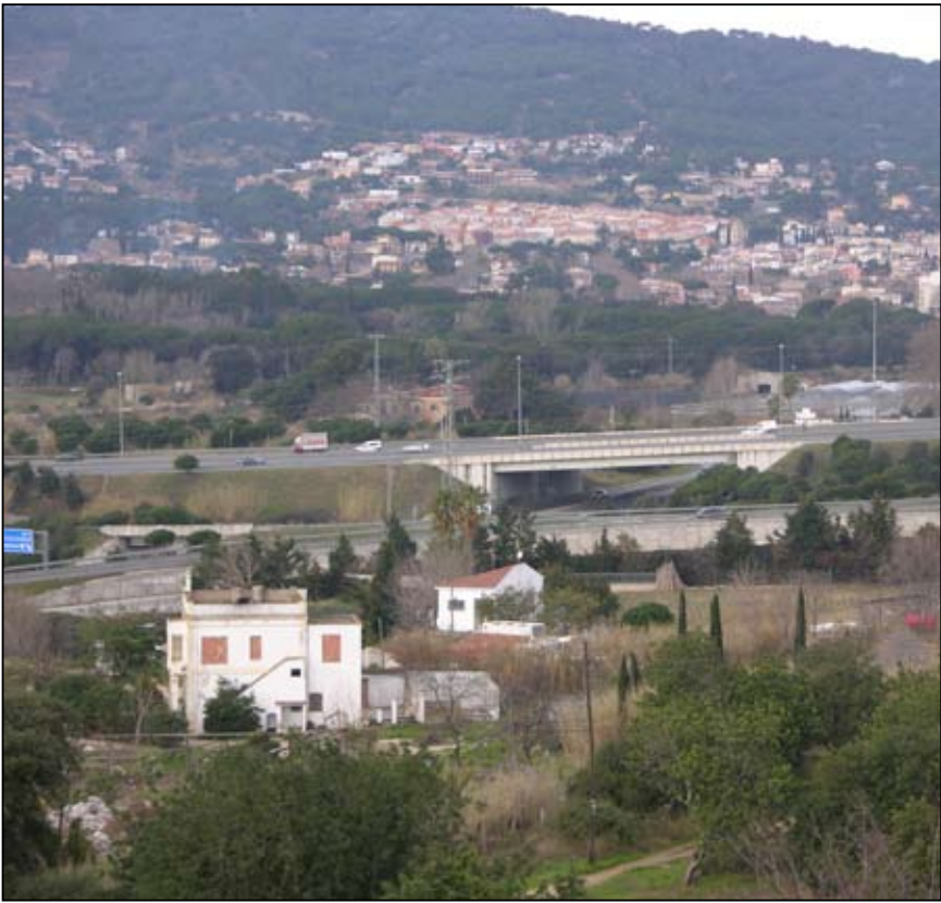
L'enllaç entre l'autopista C-32 i la C-60 fragmenta els espais lliures d'aquest àmbit, alhora que en dificulta la seva connectivitat.
