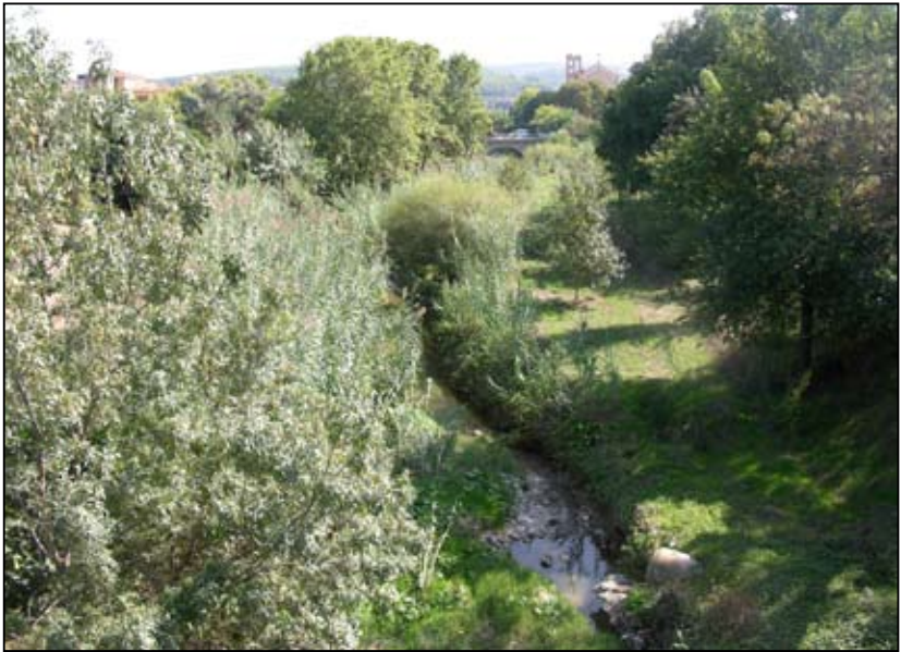
La llera del riu Foix travessant el nucli històric d'Els Monjos amb el pont de la carretera N-340a al fons.
