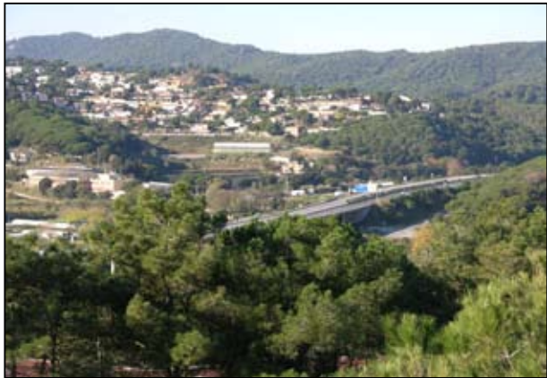
Viaducte de la C-60 amb la urbanització de les Ginesteres al fons.
