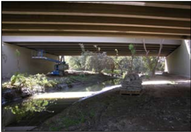
Pas de la riera de Llobregat per sota l'autopista AP-7
