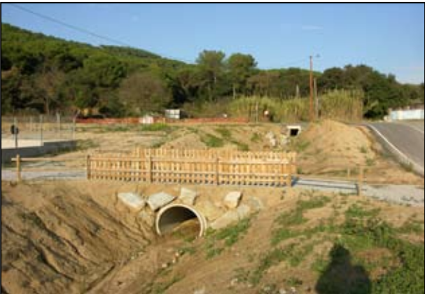
Obres d'adequació hídrica en l'enllaç viari de la BV-5101 de Llinars a Canyamars, davant de can Santpere.
