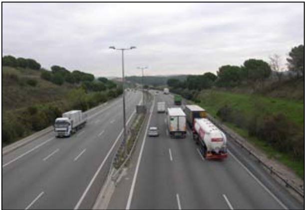
Vista des del pas superior de l'autopista AP-7 que uneix la serra de Llevant amb el sector de Quatre Camins.
