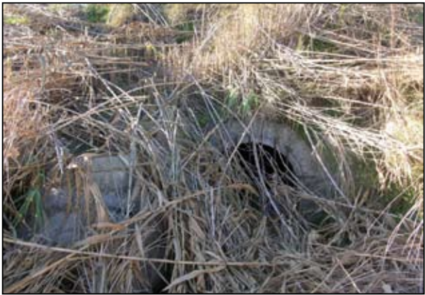
La capacitat hídrica de certs torrents en els passos més reduïts pot quedar alterada per l'acumulació de canyes després d'una avinguda.
