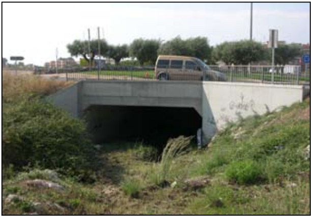
Pas del torrent de Santa Maria per sota la carretera C246 que facilita la connexió cap a la línia litoral de la costa.
