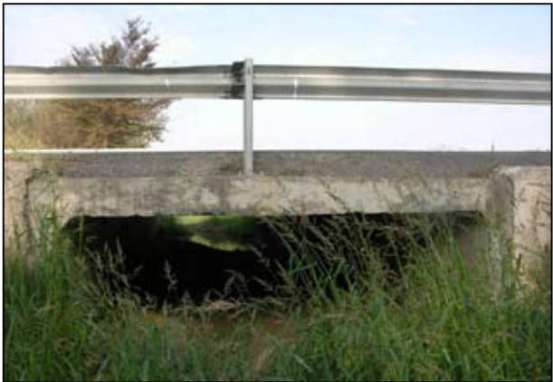
Pas de la riera de l'Adoberia per sota de la C-244 a l'entrada de Vilafranca del Penedès.
