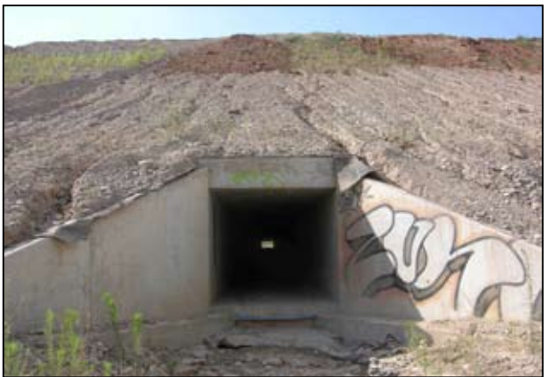
Pas per sota la traça de la Ronda del Vallès, de dimensions mínimes per la longitud que assolí.
