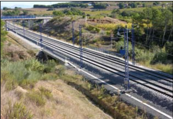
Pas del torrent de la Salada per sota la línia del tren d'alta velocitat, vist des del pont de la carretera BV-2429 a Sant Pau de l'Ordal.
