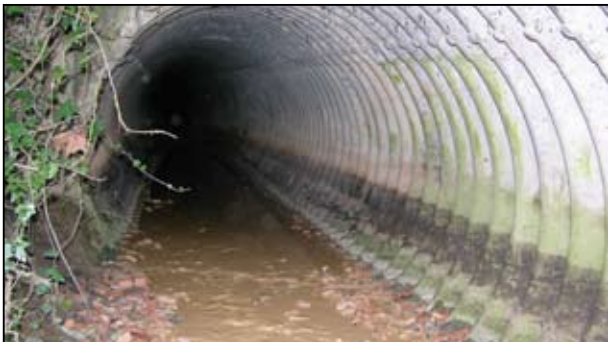
Pas subterrani del torrent de Can Fatjó (braç oest) per sota l'autopista.
