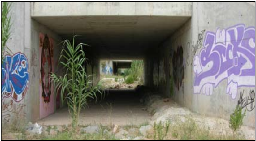
Torrent de les Mallorquines travessant amb passos soterrats per sota les infraestructures viàries de l'autovia A-2 i el tren d'alta velocitat.
