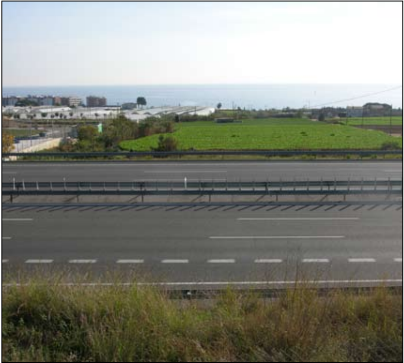
L'autopista C-32, un dels elements de fragmentació d'aquest àmbit.
