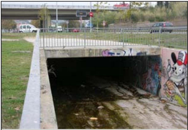
Riera de Teià sortint a l'exterior passat el viaducte de la C-32
