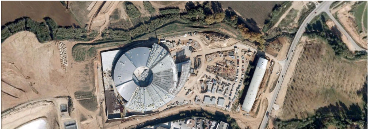
Sincrotró en construcció. Avui ja és una obra acabada en explotació
