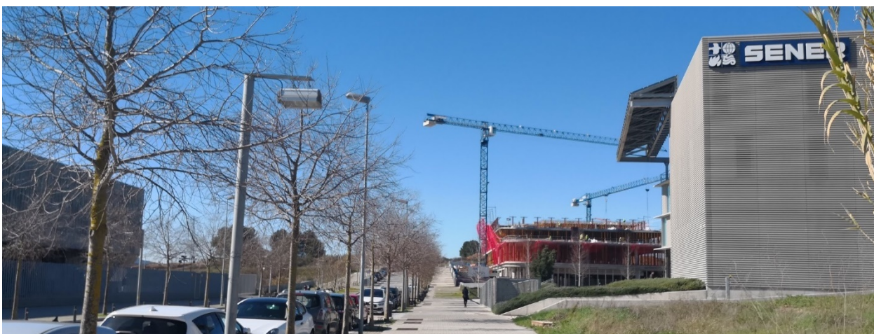
Edific SENER i un nou edifici en construcció
