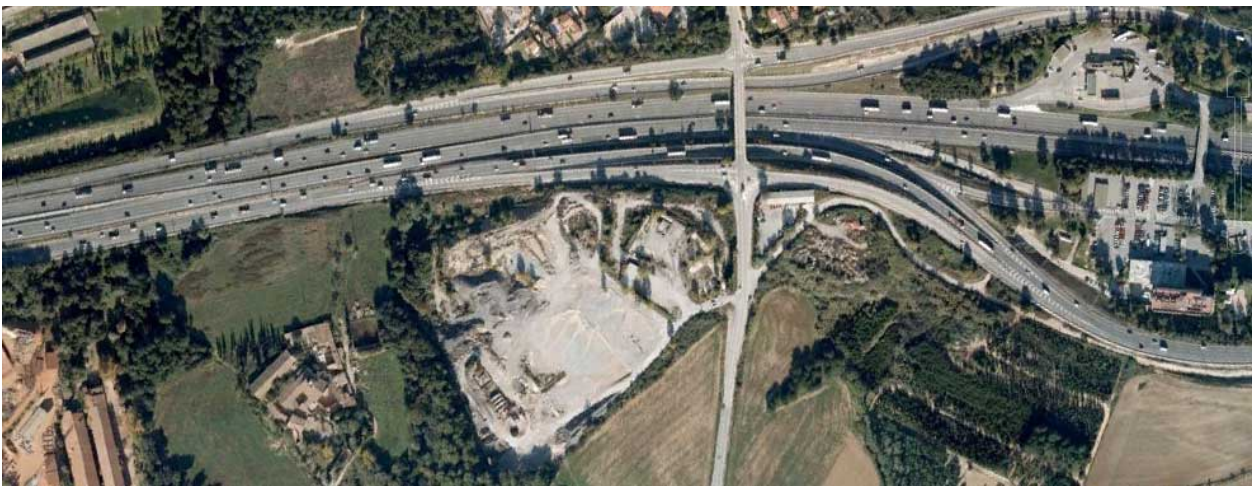
Àmbit de l'empresa Pavibar, deconstruït i en procés de descontaminació
