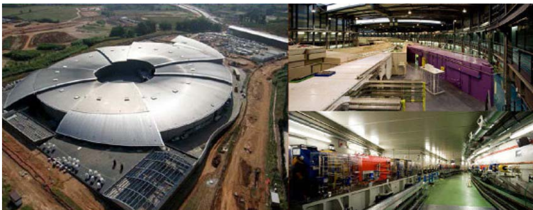
Instal·lacions del Sincrotró Alba
