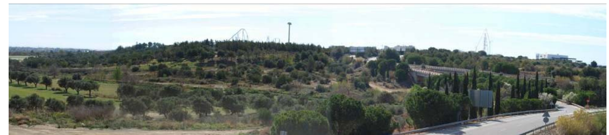
La part nord del recinte, malgrat no ser accessible, és la més visible per la seva topografia elevada i l'abundància de vies de comunicació adjacents.
