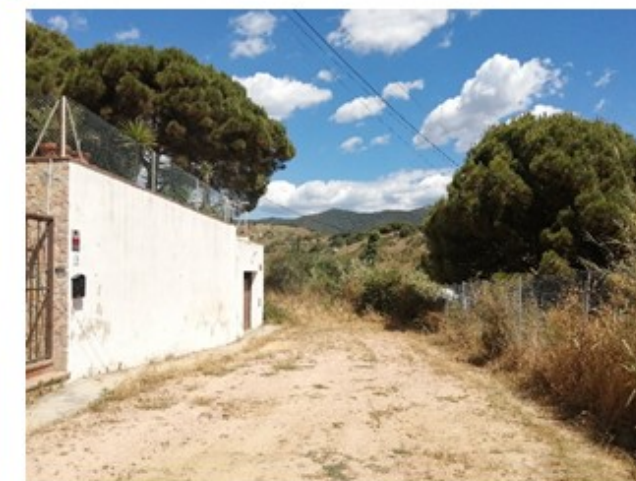
Foto 2: Imatge des del límit sud del PMU08 on s'observa la manca d'obertura de la continuïtat del carrer previst pel planejament vigent i la manca de xarxes de serveis urbans.
