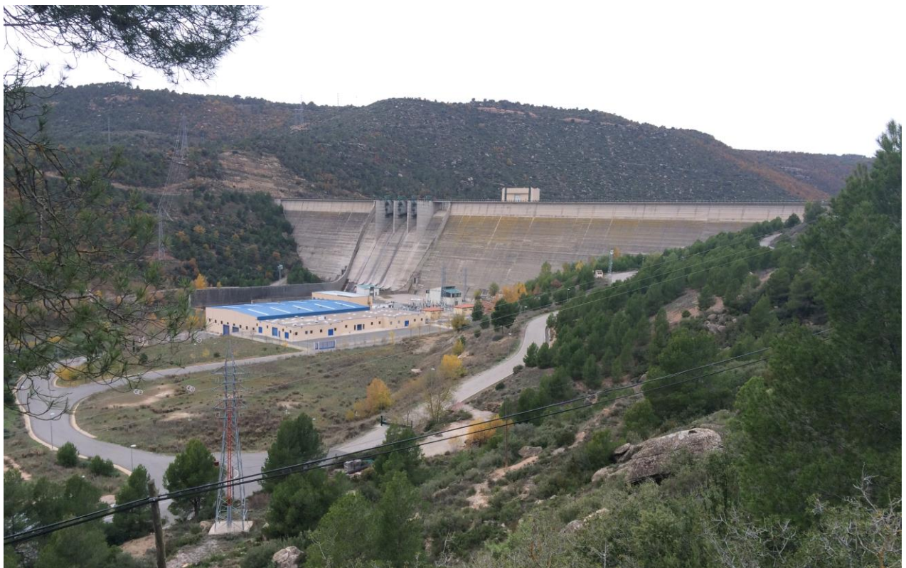
Imatge de la presa de l'embassament
