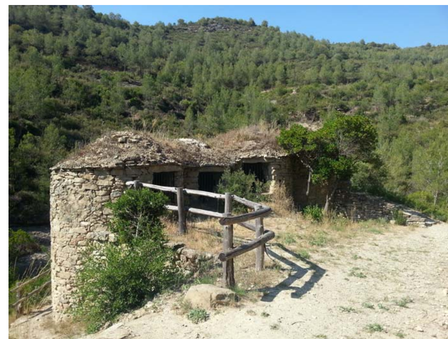
Figura 23.14 Les construccions de pedra seca, com aquestes tines, actualment se situen enmig de les masses boscoses de la unitat.
