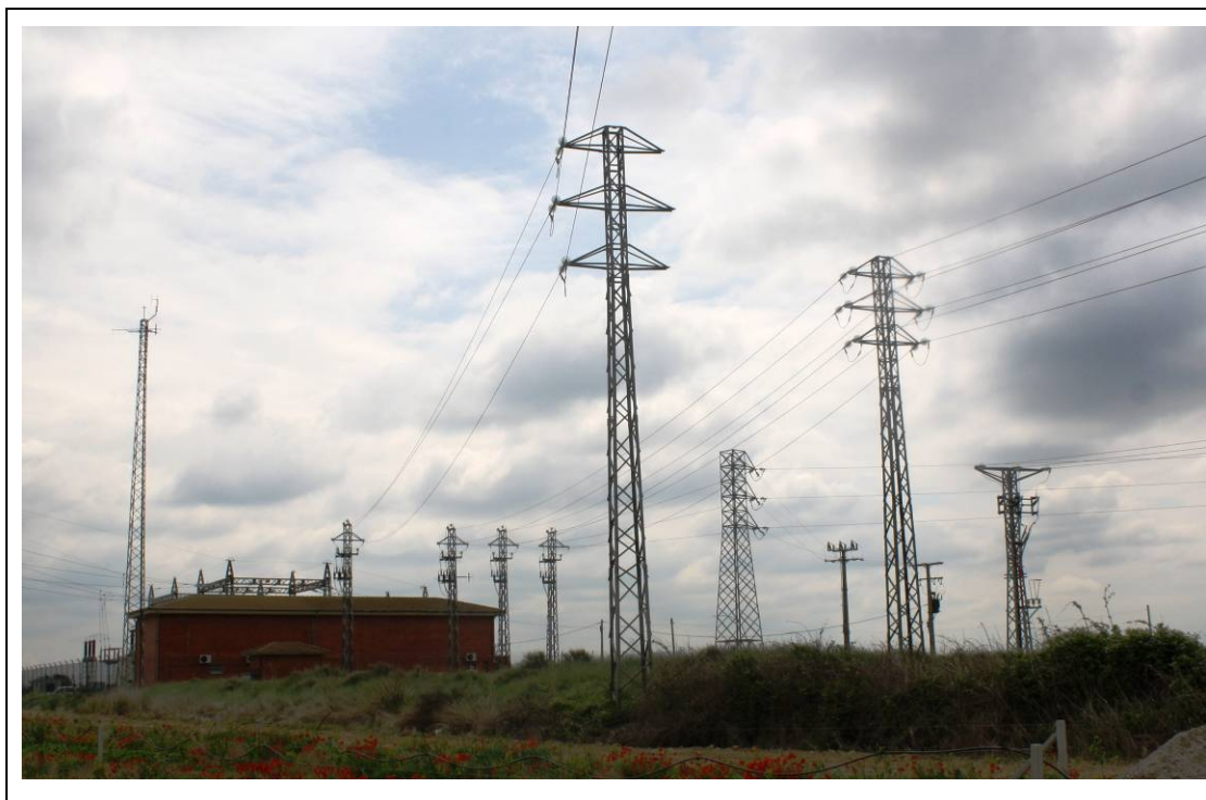
Foto 2: Vista de la S.E. SEGRÀ, inici de la línia objecte de l'estudi.
