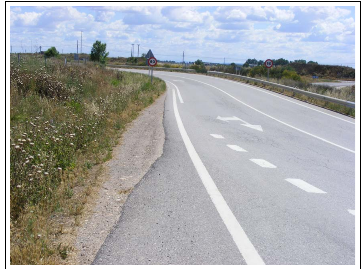
Foto 6: A.P. 1, Enllaç amb la carretera N-240. Inici A.P. 1, zones ermes als marges de la carretera. Zona del J.A. Pla de la Creu.
