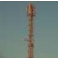
Las estaciones de telefonía móvil normalmente se instalan en lo alto de edificios o en torres a alturas de entre 15 y 50 metros y emiten ondas de radio que se propagan de forma casi paralela al suelo.
