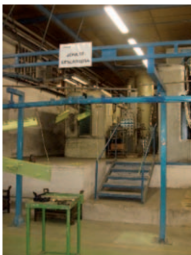
Figura 2. Instal·lació de pintat industrial
