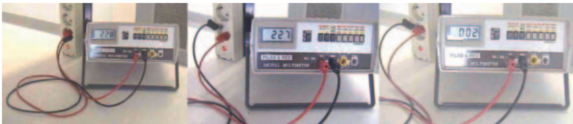
Figura 4. Mesura de la tensió de xarxa i detecció de fase i neutre en una mateixa base. Observeu que el conductor negre es connecta a terra en les figures b) i c), mentre que el vermell es connecta a la fase i al neutre, amb mesures properes a 220 V i 0 V respectivament.
