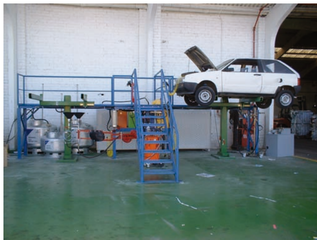
DESCONTAMINACIÓ: aparells elevadors
