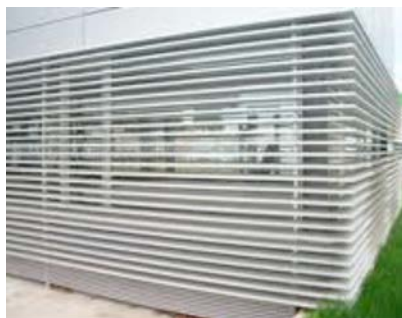
Integració lames metàl·liques horitzontals de protecció solar
