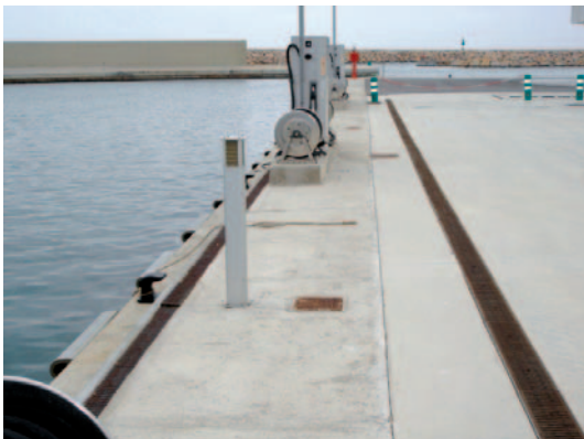
Reja interceptora en la zona de la gasolinera en el Port Segur-Calafell
