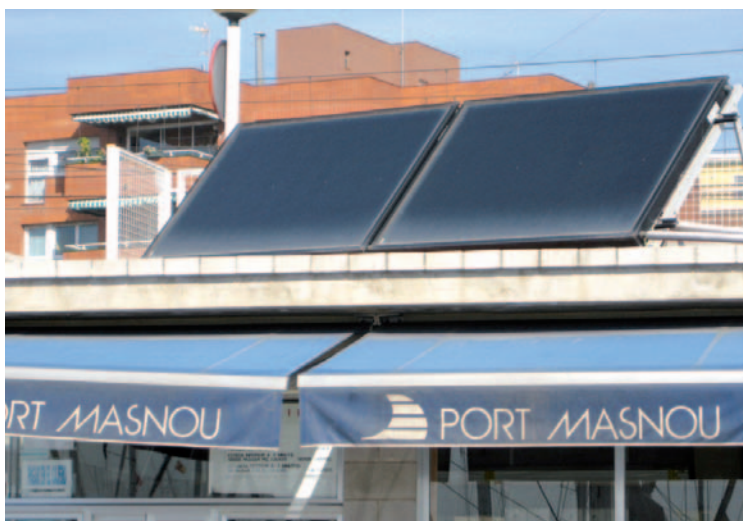
Placas fotovoltaicas en el Port Masnou
