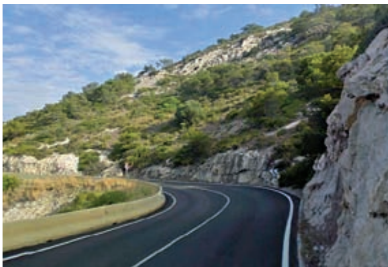
Imatge 3.22 Barrera de formigó amb tractament superficial - © CICSA
