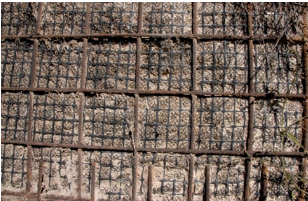
Imatge 3.15 Detall de l'estructura - © DTES
