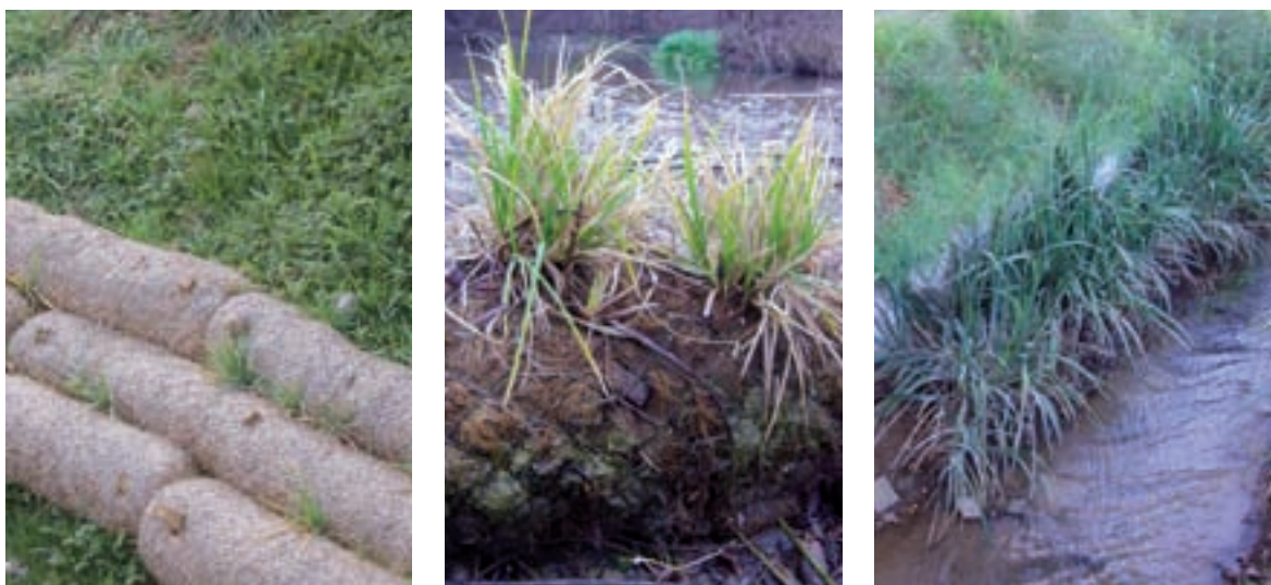
Imatge 4.35 Detall de la implantació de biorotlles - © EGAM, SL
