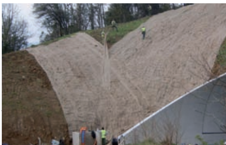
Imatge 4.5 Instal·lació de mantes orgàniques © EGAM, SL
