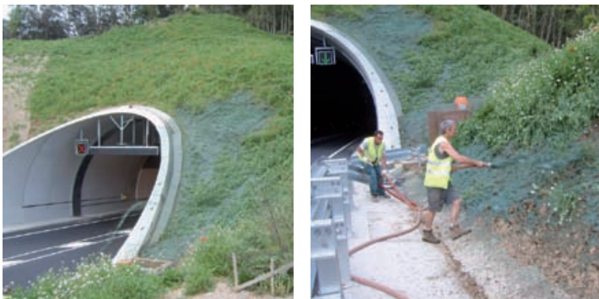
Imatge 4.2 Hidromanta - © EGAM, SL
