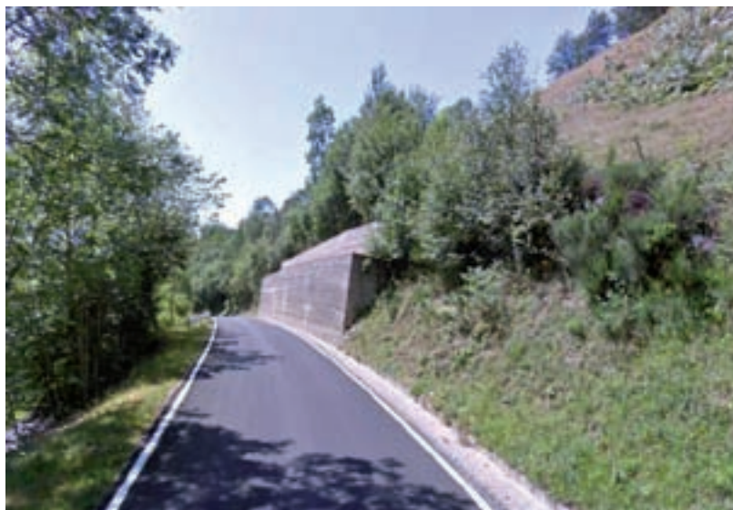
Imatge 3.11 Mur de formigó a la carretera de Molló GIV-5225 (Ripollès) - © CICSA
