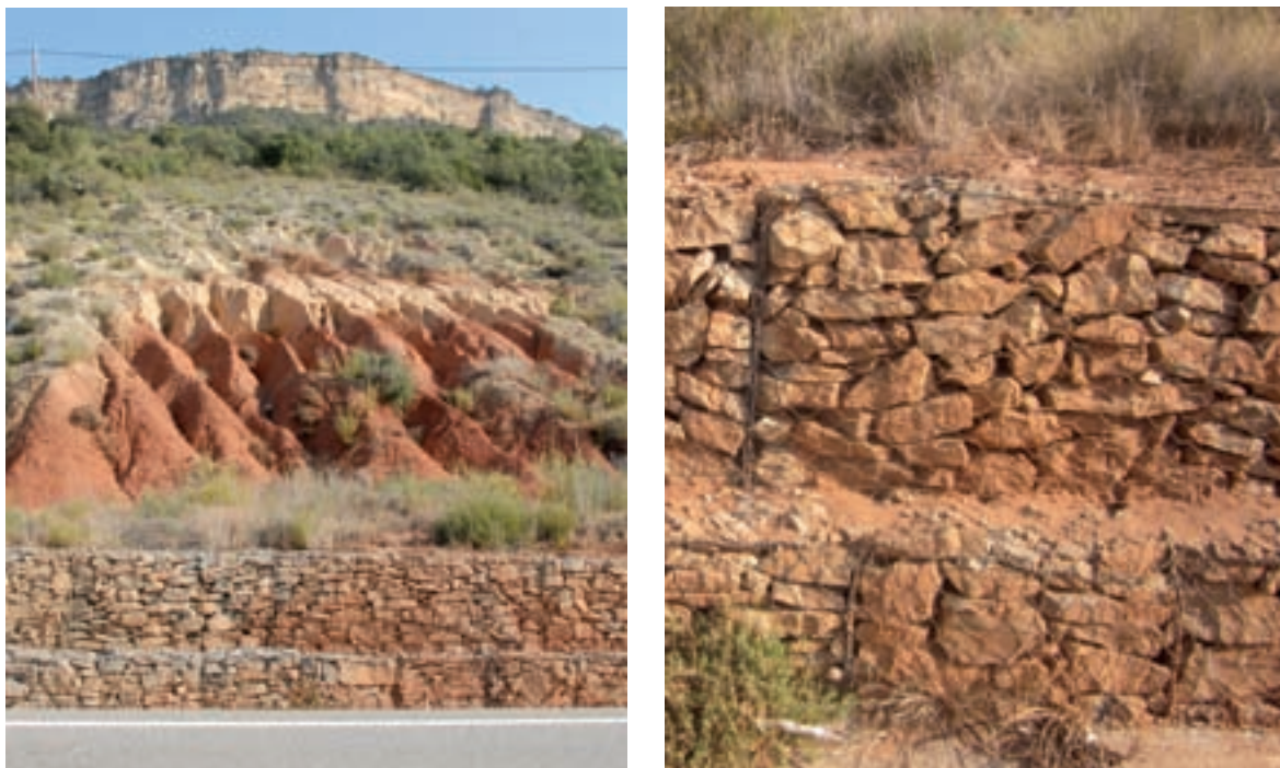
Imatge 3.13 Mur de gabions a la C-13 - © DTES
