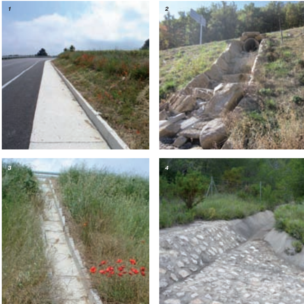
Imatge 3.7 Elements del drenatge longitudinal:
