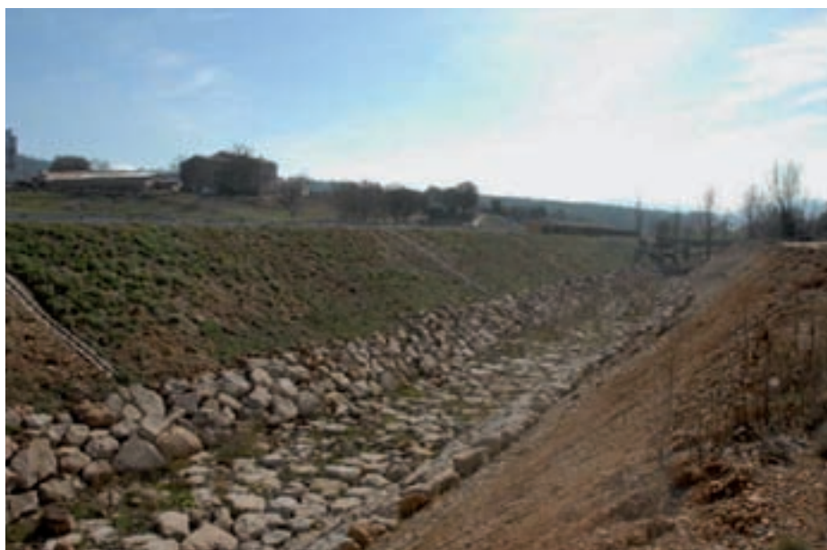
Imatge 4.31 Endegament d'una riera - © EGAM, SL
