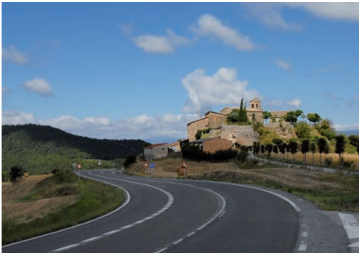
Imatge 2.5 Carretera C-26. Castellar de la Ribera - © DTES
