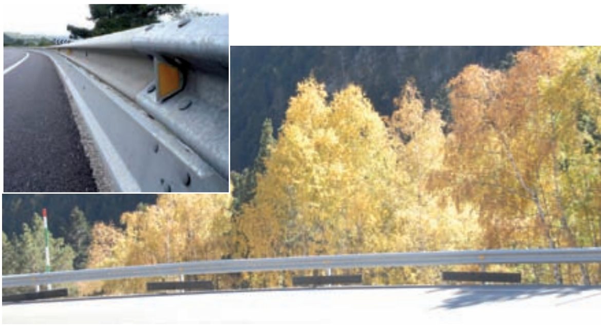
Imatge 3.24 Barreres metàl·liques - © CICSA i mixta - © DTES protegides per als motoristes
