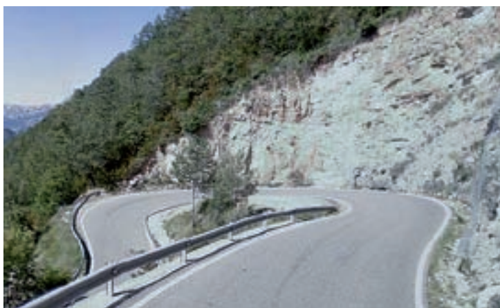
Imatge 3.3 Corba en ferradura a la Carretera de Berga BV-4241 - © CICSA
