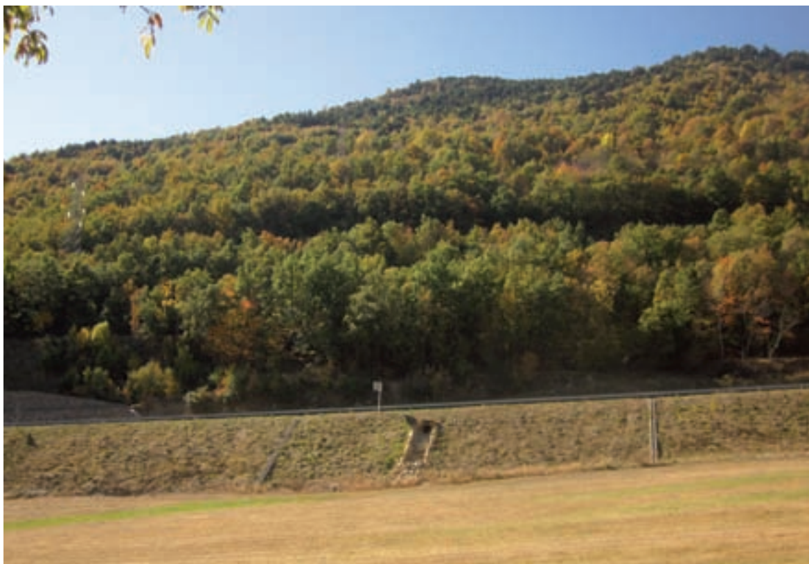
Imatge 3.9 Talussos revegetats en terraplè - © DTES
