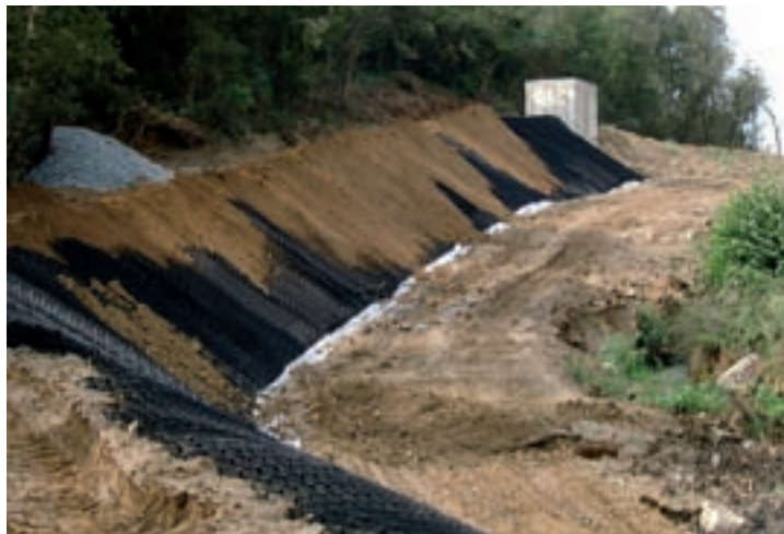
Imatge 4.21 Treballs d'estabilització de talussos amb geocel·les - © EGAM,SL
