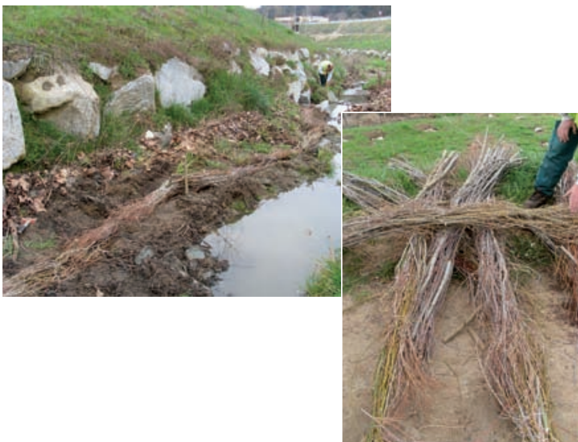
Imatge 4.34 Detall de feixines vives - © EGAM, SL
