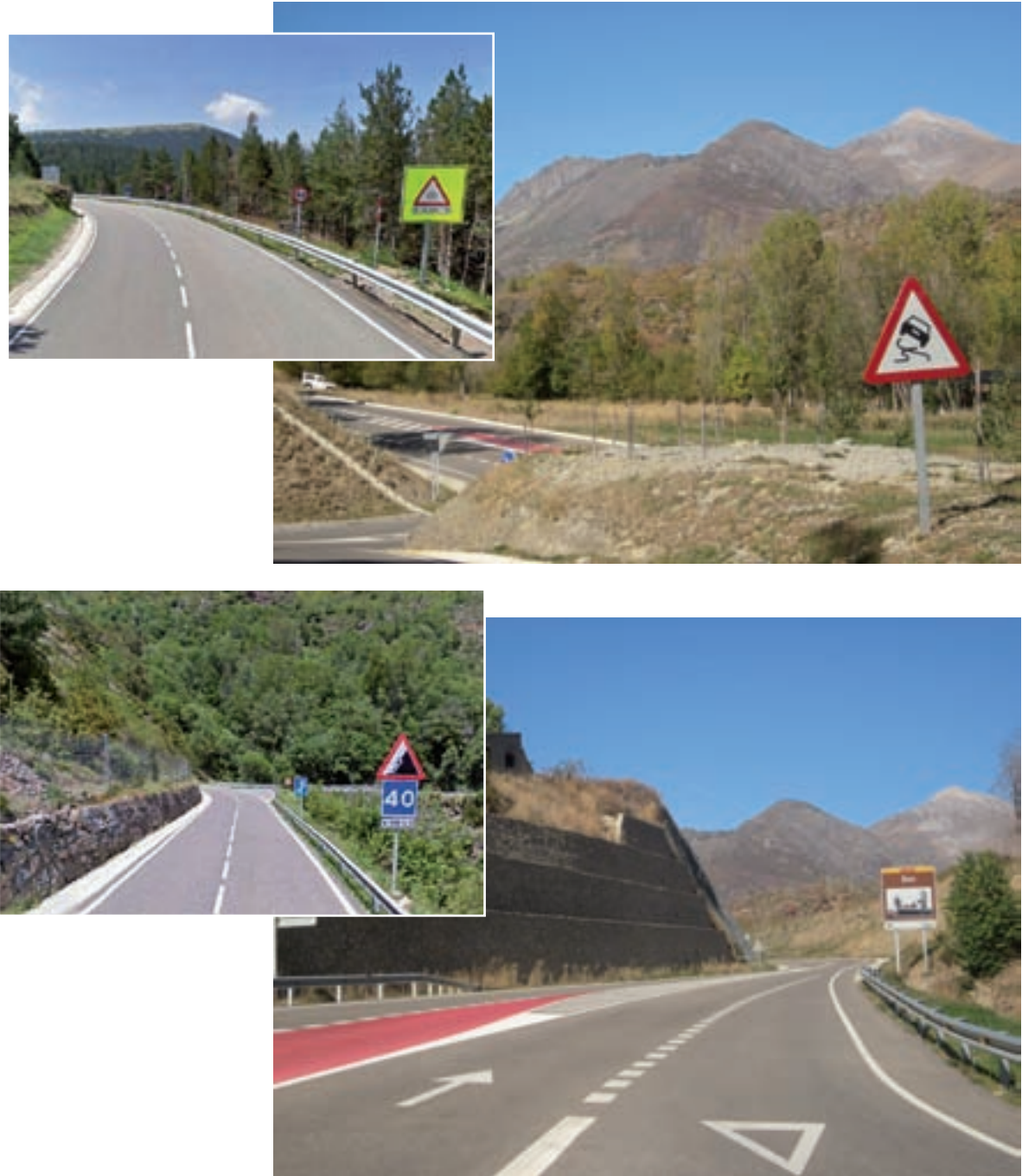
Imatge 3.26 Senyalització vertical i horitzontal en carretera de muntanya - © DTES - © CICSA
