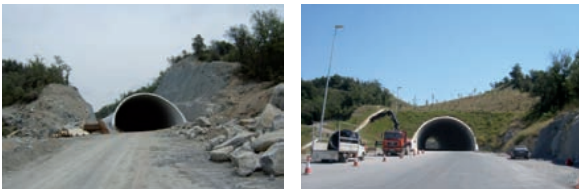
Imatge 3.16 Construcció del fals túnel de la Cavorca a la C-37 - © EGAM
