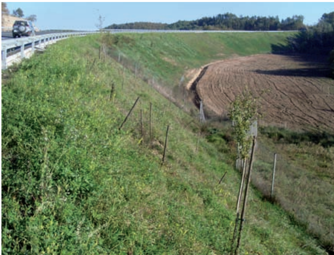
Imatge 5.3 Mesures correctores en la restauració de talussos - © EGAM,SL
