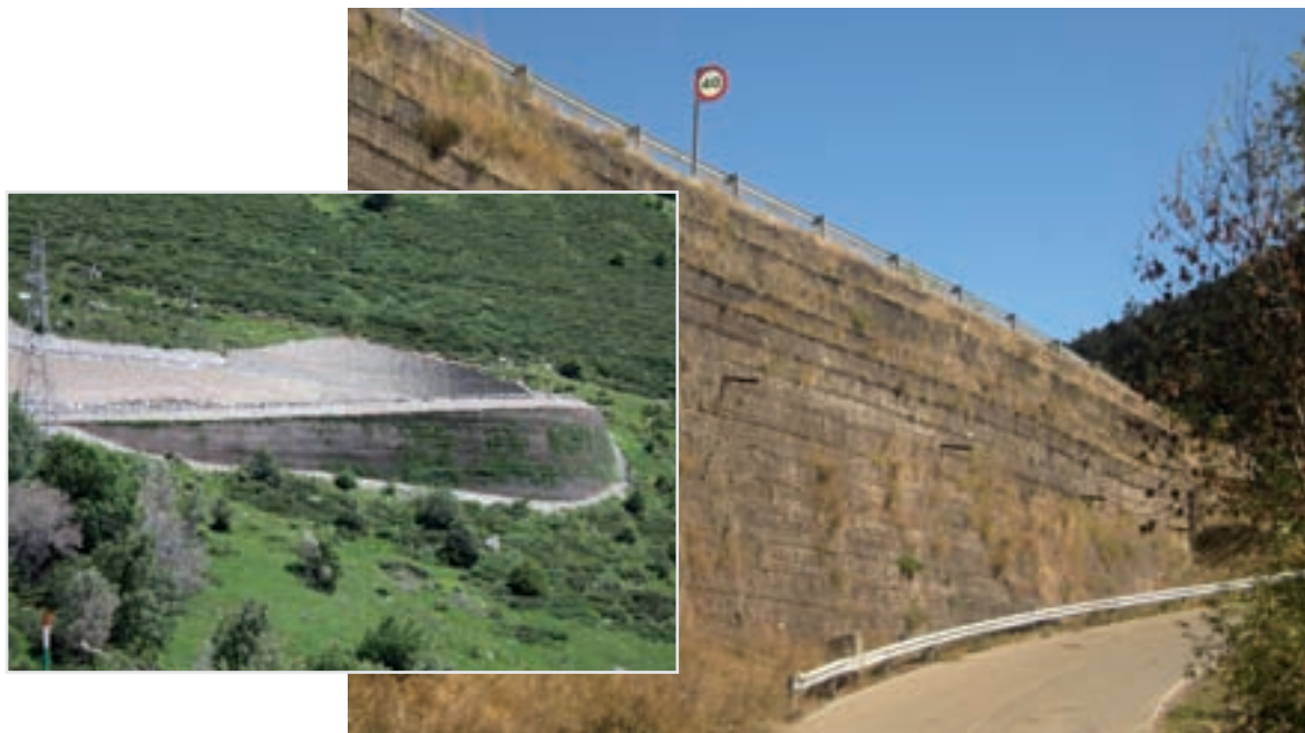
Imatge 3.14 Exemples de murs mixtos - © CICSA - © DTES
