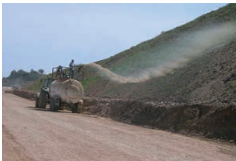
Imatge 4.1 Hidrosembra normal - © EGAM, SL
