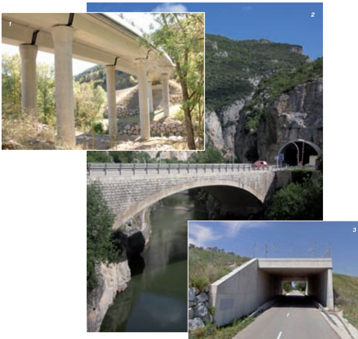
Imatge 3.18 Obres de fàbrica
