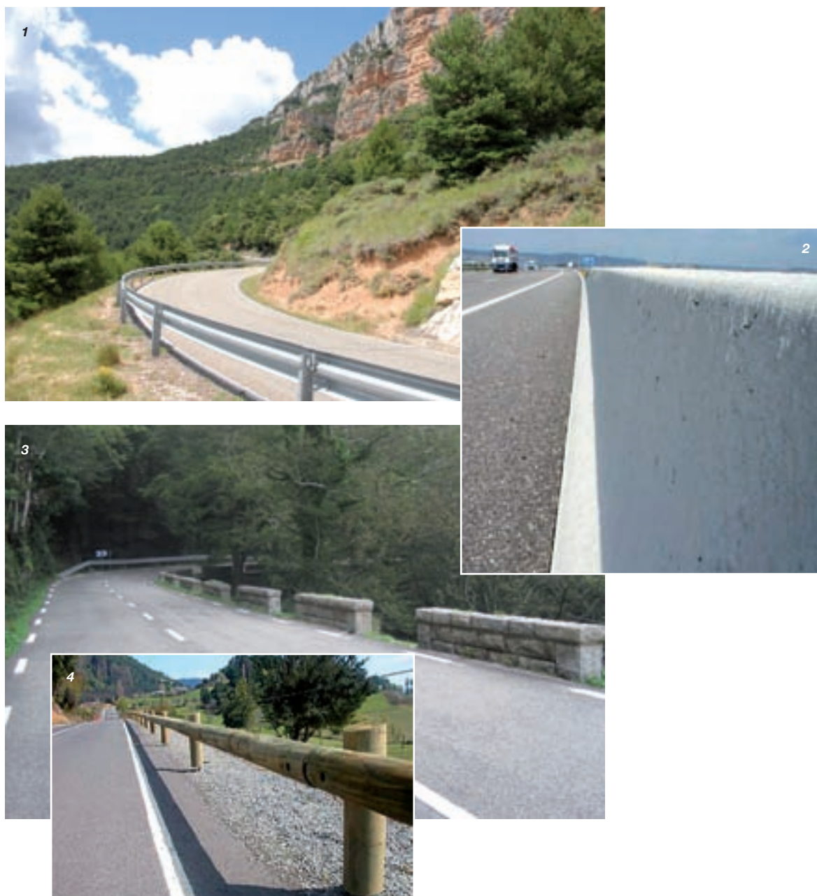
Imatge 3.21 Barreres de protecció
