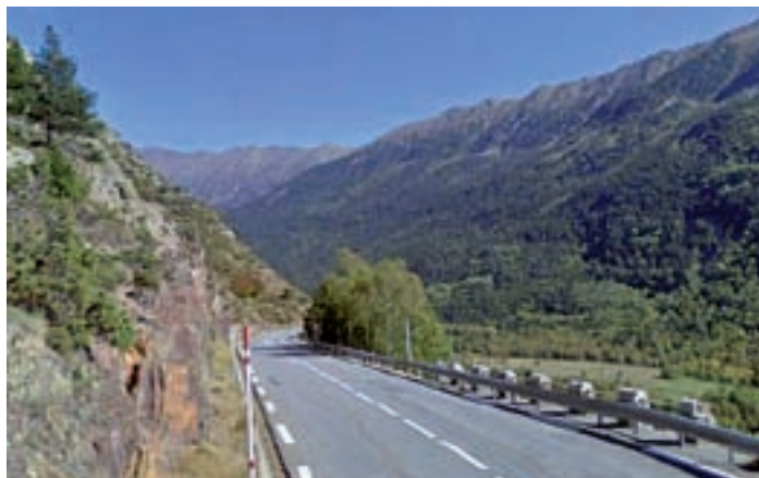
Imatge 3.23 Barrera de mur de pedra que s'ha hagut de suplir per una de metàl·lica - © CICSA
