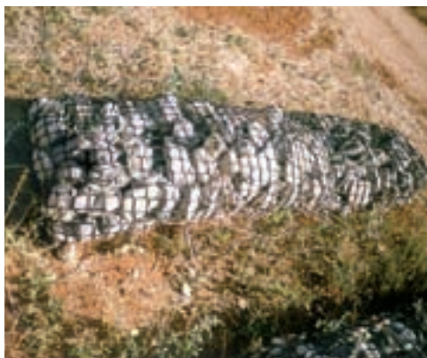
Imatge 4.22 Gabions flexibles - © Naturalea Conservació, SL
