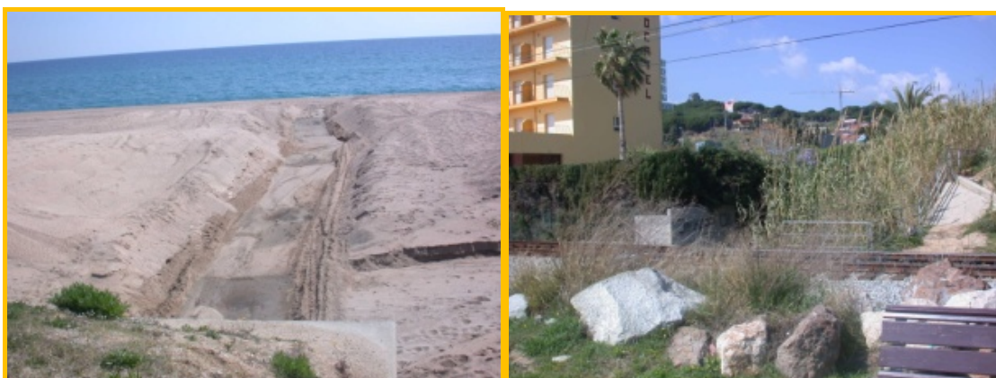
Fig. 7: Riera de Sant Elm-Gavarra (imatge 1 en direcció a la platja, imatge 2 en direcció contrària). El camí transcorre per sobre de la canalització.
