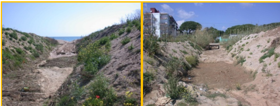
Fig. 6: Rial de Vallmaria (imatge 1 en direcció a la platja, imatge 2 en direcció contrària). El camí passa per una obra de fàbrica de 4 m d'ample per sobre el rial
