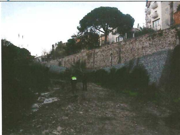
1 Vista del gual abans dels treballs
