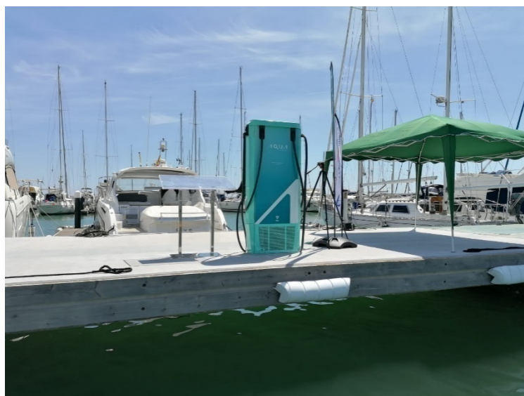
Punt de recàrrega de vaixells elèctrics de la Marina Sant Carles
