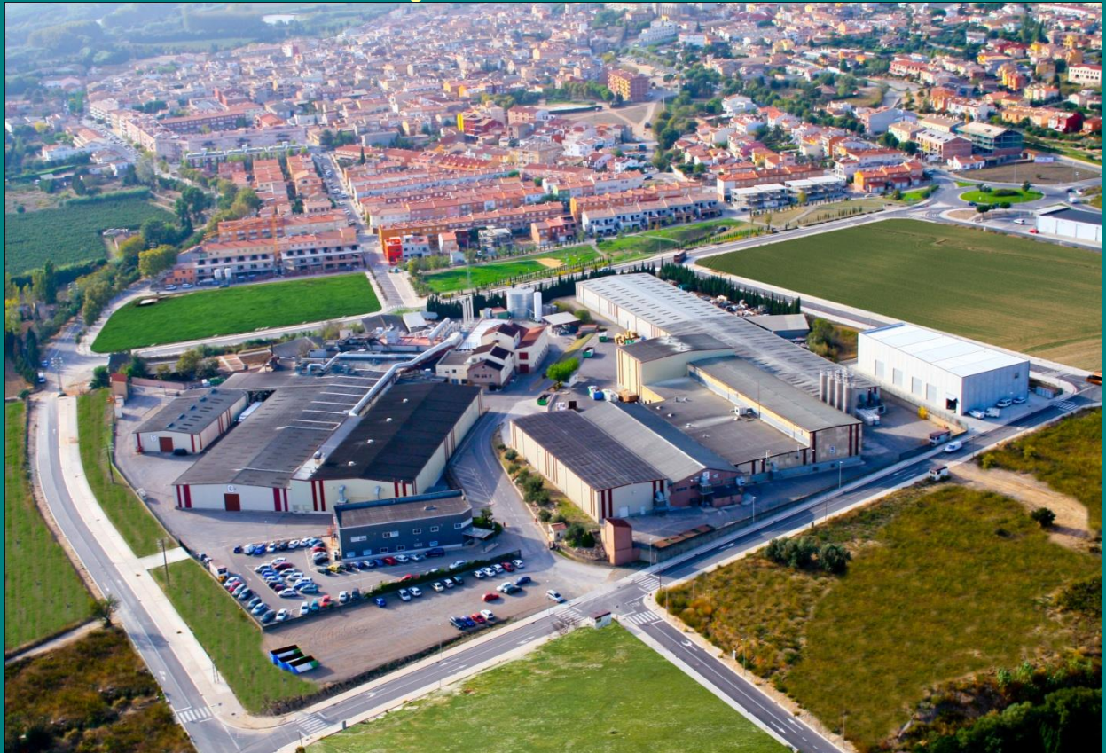
Fig. 10: Vista aérea de la factoría ENPLATER S.A. en Torroella de Montgrí.
