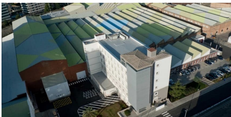
Figura 1: Vista aérea de la planta industrial, en el municipio de Cornellá de Llobregat
