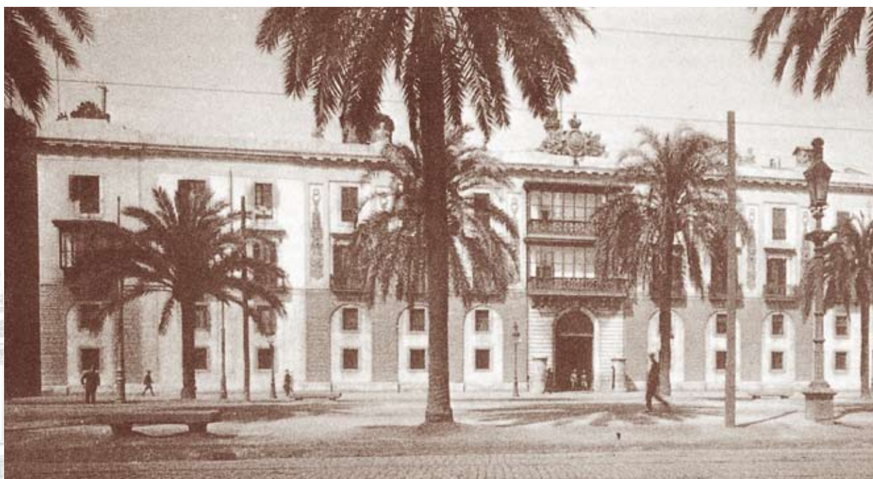
Façana del Palau cap al 1879, en què en podem observar els elements decoratius. Detall de l'ornamentació de terra cuita que decora actualment el vestibul de l'escala d'honor
