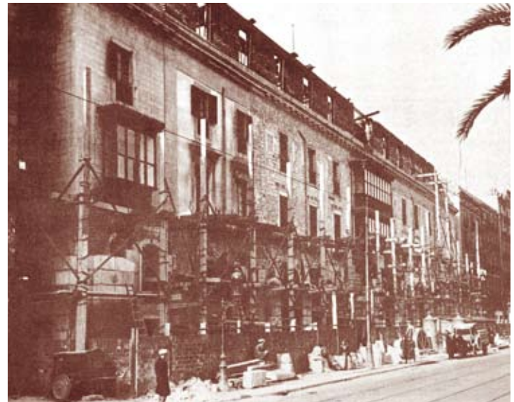
La mateixa façana del mar durant les obres de reforma
