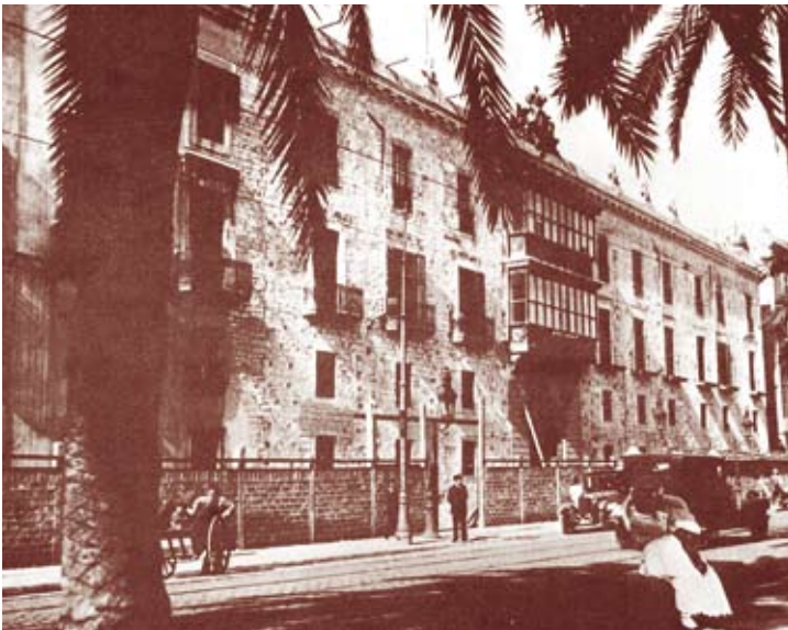
La façana del mar, abans de la reforma
