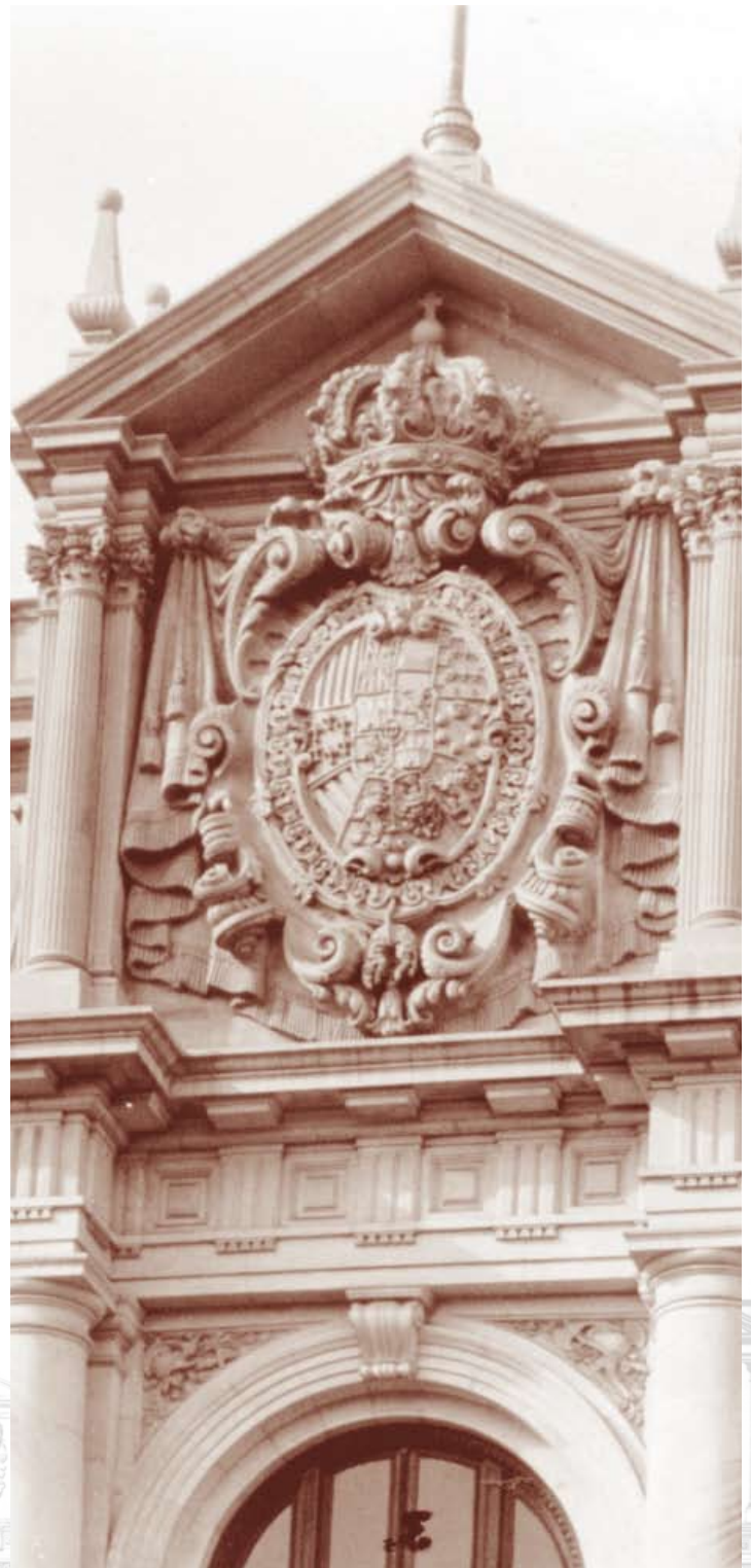
Detall del frontó de la façana del passeig de Colom
