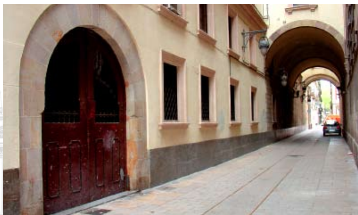
La porta del tragí, que servia per al servei, amb els ponts que, sobre el carrer de la Mercè, uneixen la basilica i el palau
