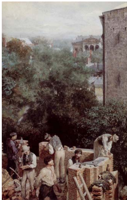
Imatge A. Adolph Menzel (1815-1905): Paletes en un edifici en construcció , 1875. Gouache, 40 x 26 cm, Col·lecció privada, Essen.
